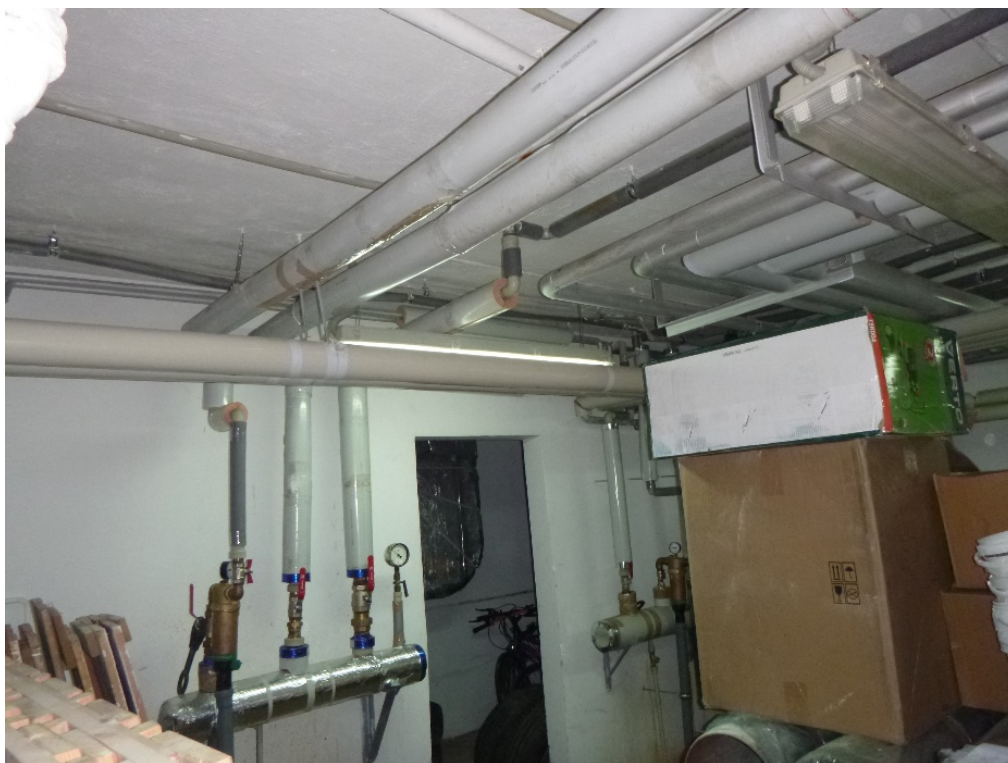
Fot 8 rozdzielacz wody zimnej w podwężle sali sportowej
