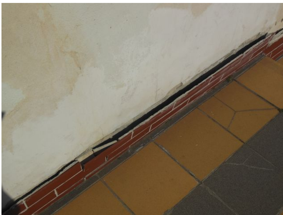
Zdjęcie nr 14 – Płytki cokoliku przyściennego odspojone od ściany ośrodka sportowego
