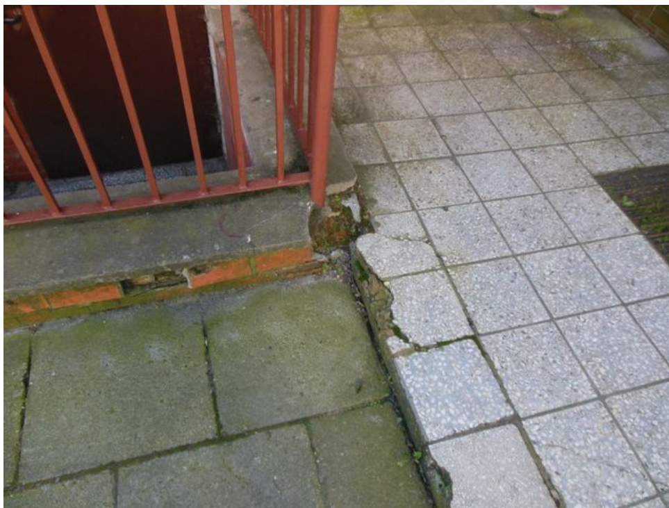
Zdjęcie nr 17 – Przy wejściu do piwnicy ośrodka sportowego zniszczone płyty ciągów pieszych
