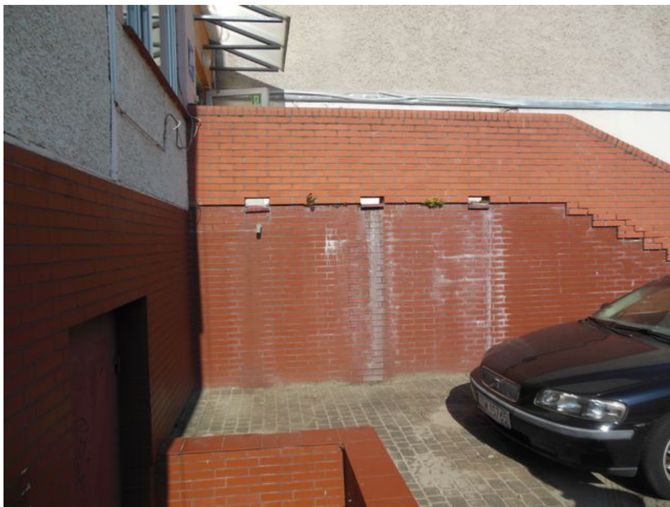
Zdjęcie nr 13 – Zacieki na ścianie obudowy biegu schodowego zewnętrznego klatki schodowej ośrodka sportowego
