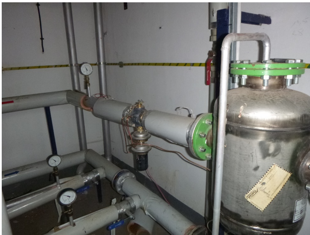
fot 29 Uszkodzenia izolacji na module przyłączeniowym węzła
