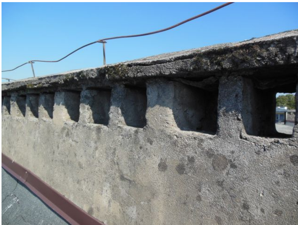
Zdjęcie nr 25 – Murki kominów wentylacyjnych są częściowo zmurszałe. Widoczne na „czapkach” pręty zbrojeniowe.
