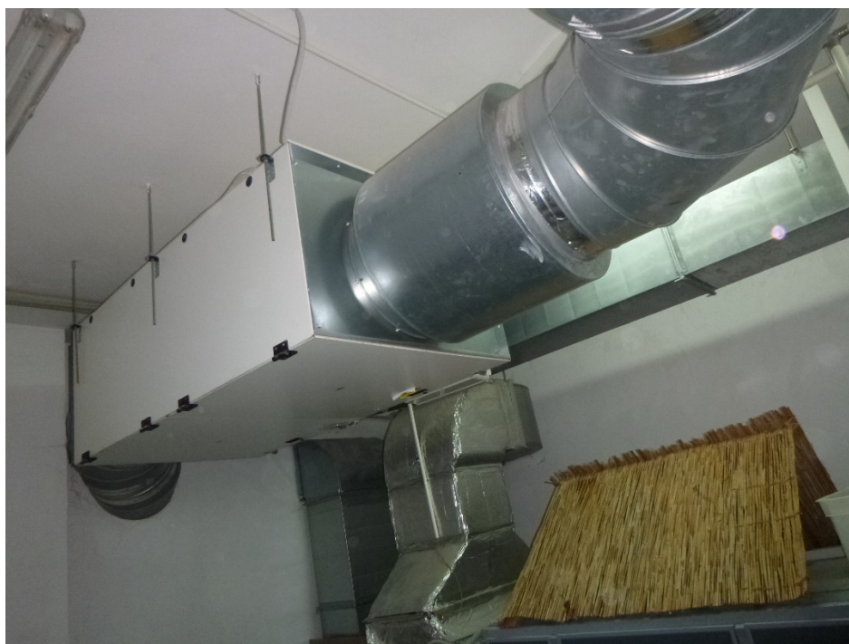
fot 56 Układ N5 - centrala nawiewna w wentylatorni
