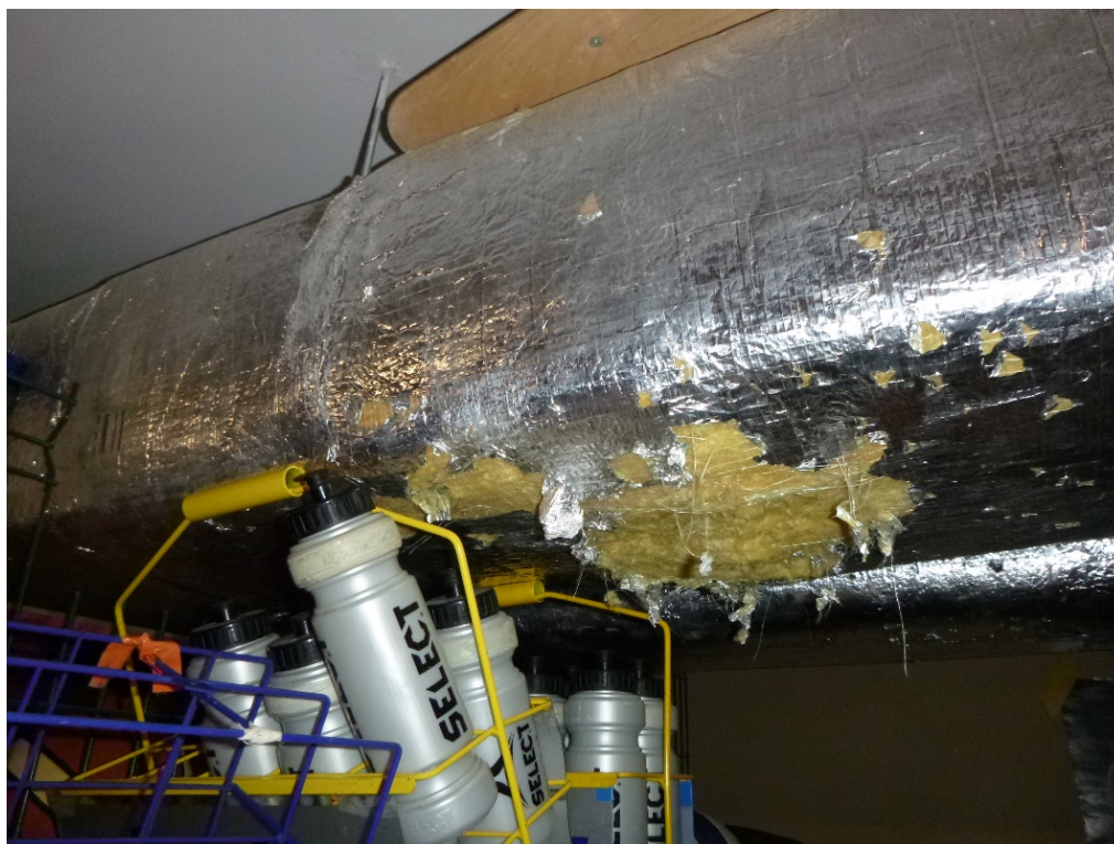
fot 40 Układ NW2. Kanały nawiewu i wywiewu. Uszkodzona izolacja.
