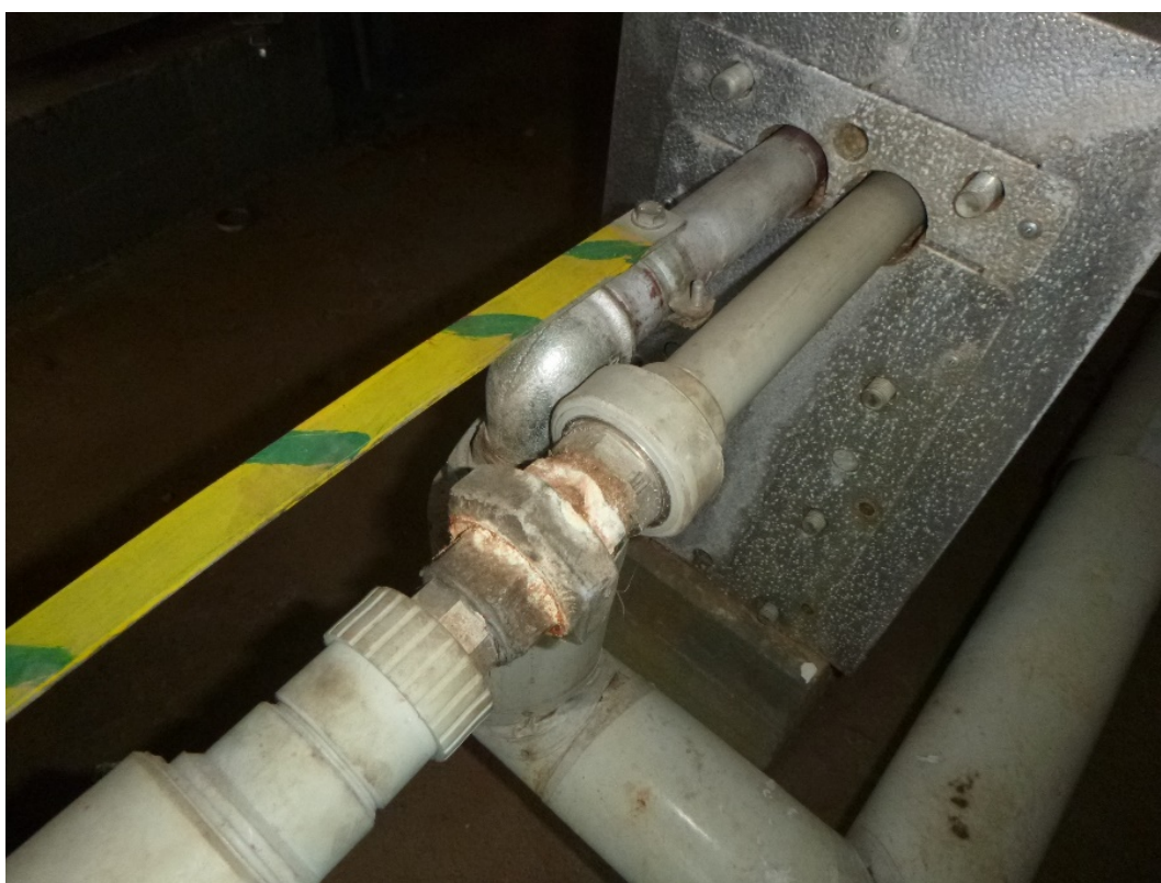
fot 31 Lokalne przecieki z widocznym osadzeniem kamienia
