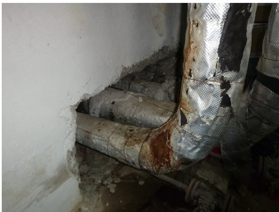
fot 6 przewody zasilania z węzła ciepłego (wejście z kanału na korytarz segmentu sportowego) (c.o., cyrkulacja, c.t., c.o)
