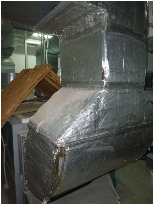
fot 54 Układ NW4. Kanał w wentylatorni. Kanały do wyrzutni z uszkodzoną izolacją.
