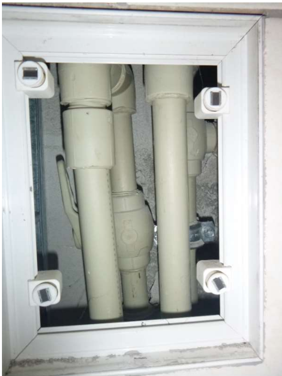
Fot 11 Instalacja w szachcie sanitariatów parteru segmentu sportowego (ogólnodostępnych). Braki izolacji instalacji
