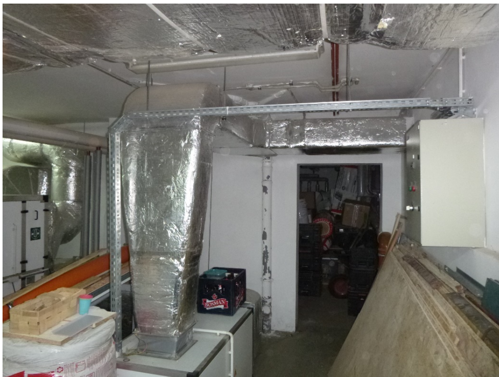
fot 43 Układ N3. Centrala nawiewna i kanały w wentylatorni
