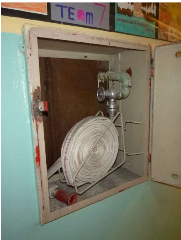
Fot 14 hydrant H25 z węzłem płaskoskładanym. Piwnica części dydaktycznej (front szafki j.w.)
