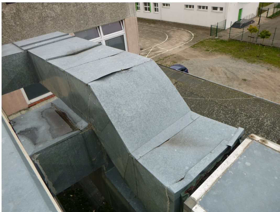
fot 34 Układ NW1. Hala sportowa. Centrala dachowa – uszkodzenia płaszcza kanałów
