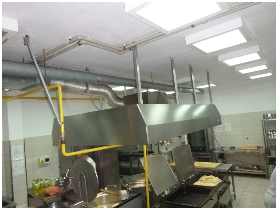
fot 59 Układ W5 – okap wywiewny Ok1, nieizolowane kanały wywiewne z Ok1 i pieca konwekcyjnego pod stropem
