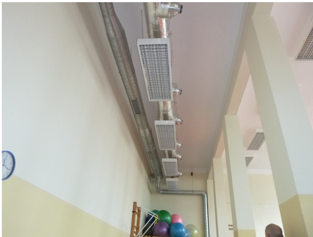
fot 45 Układ N3 i W3. Kanały pod stropem pom. rehabilitacji
