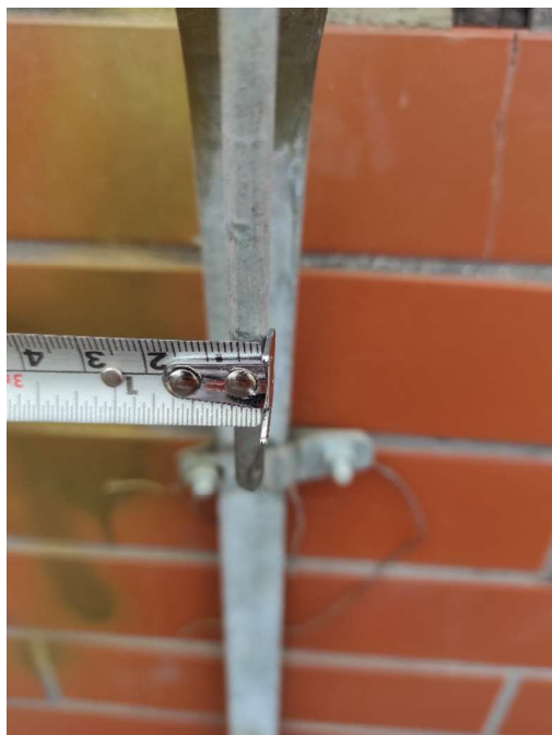
Zdjęcie nr 15 – istniejąca instalacja odgromowa – przewody odprowadzające
