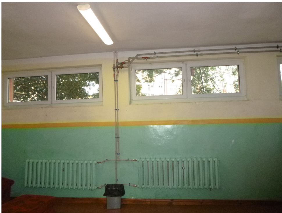
fot 16 Poziom c.o. w piwnicy i podejście pod stalowe piony
