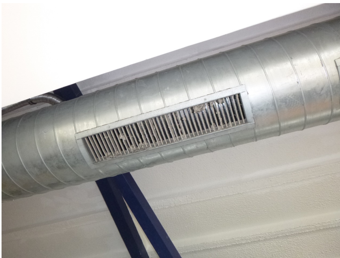
fot 36 Układ NW1. Hala sportowa. Zanieczyszczenie kanałów w hali.
