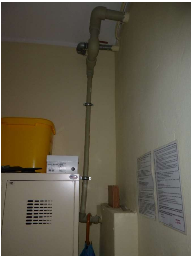
fot 13 Zasilenie hydrantu przewodem PP zgrzewanym w segmencie dydaktycznym
