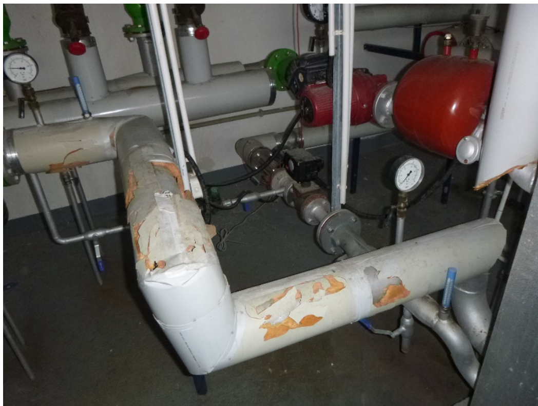
fot 32 Uszkodzenie izolacji i płaszcza osłonowego
