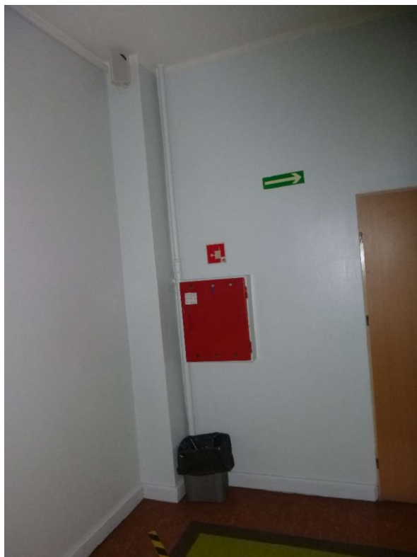
Fot 15 hydrant H25 z węzłem płaskoskładanym. Piwnica części dydaktycznej
