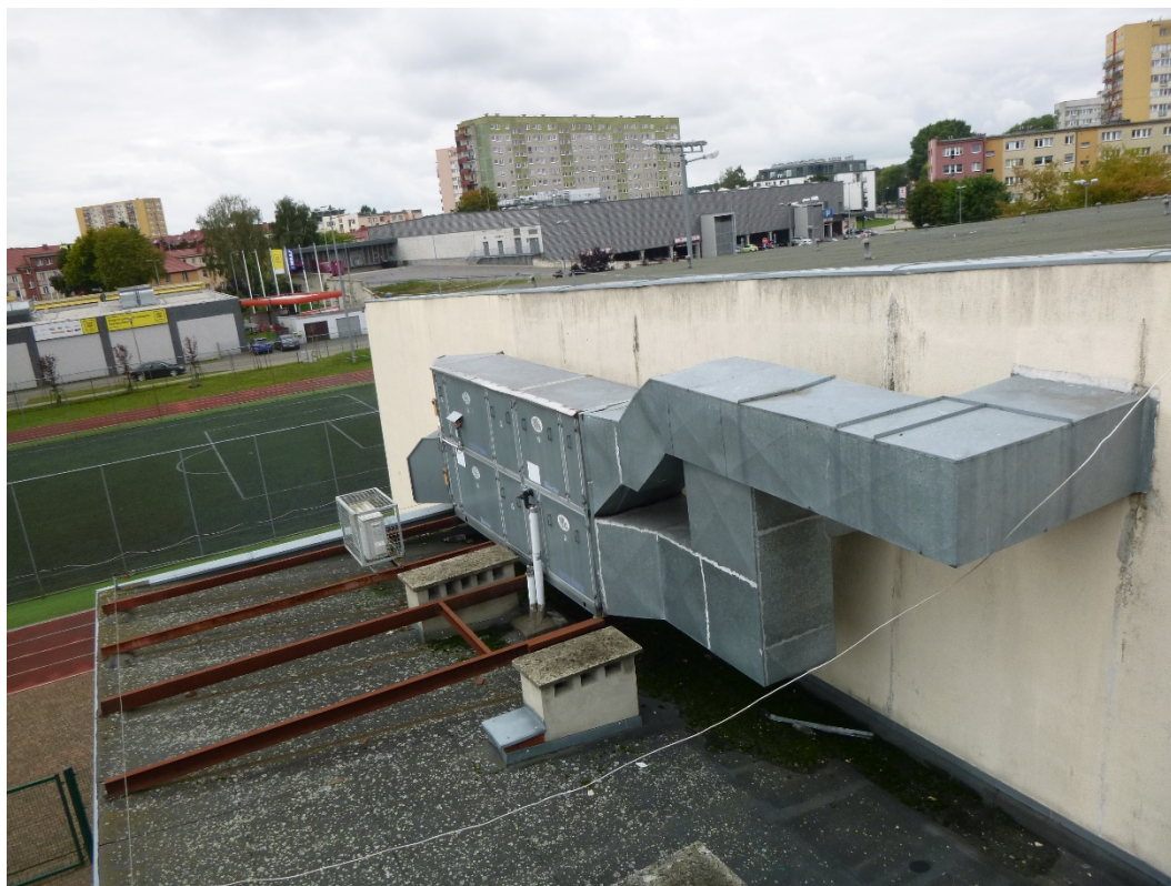
fot 33 Układ NW1. Hala sportowa. Centrala dachowa
