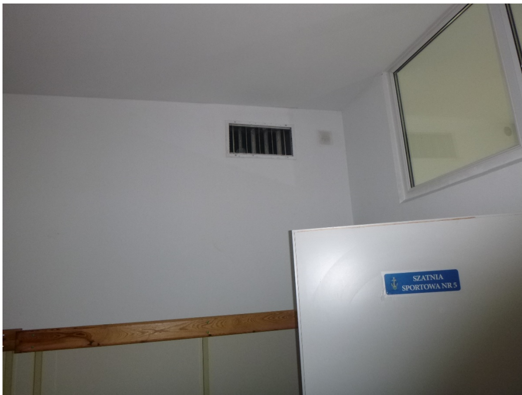
fot 41 Układ NW2. Uszkodzona kratka nawiewna do szatni przy hali sportowej.
