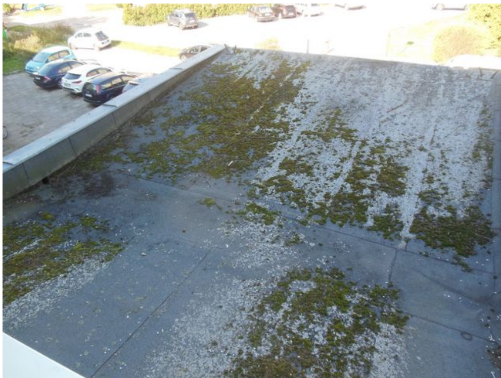
Zdjęcie nr 21 – Widok dachu nad wejściem głównym. Powierzchnia jest bardzo zniszczona. Papa bardzo wyeksploatowana.
