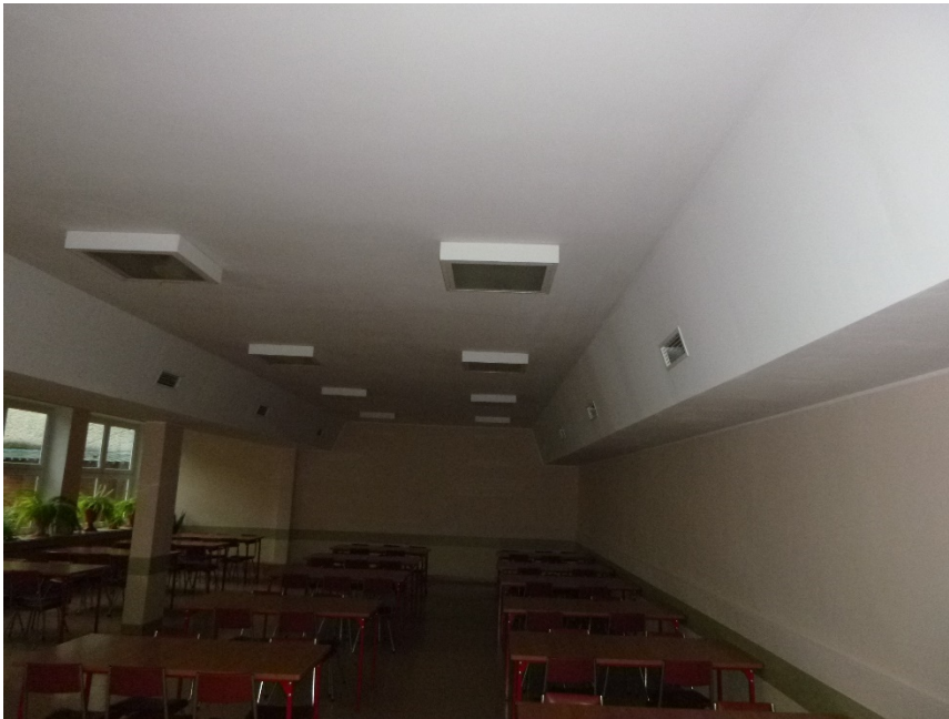
fot 52 Układ NW4 stołówka. Kanały w zabudowie pod stropem.
