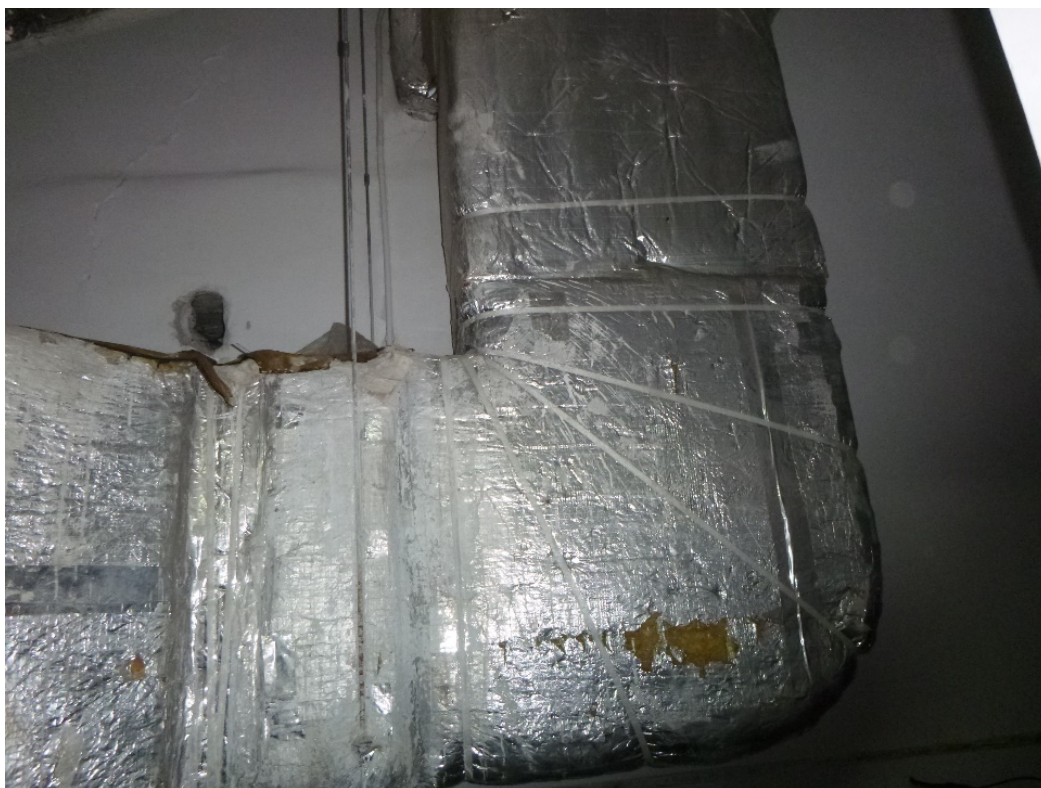
fot 38 Układ NW2 + N3. Kanał czerpny wspólny
