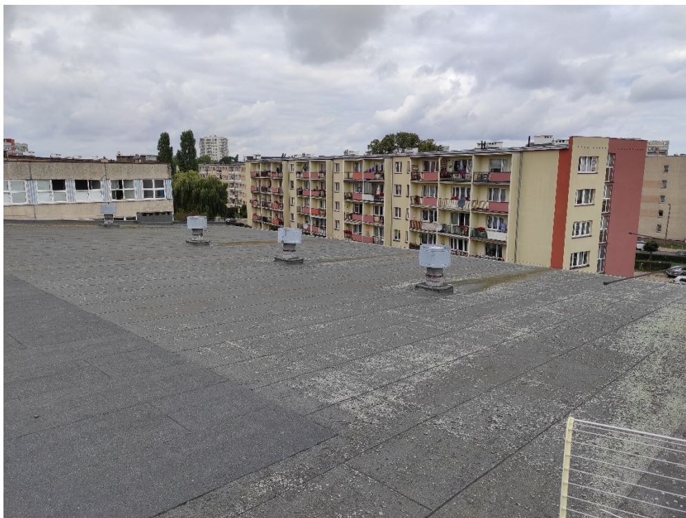
fot 48 Układ wywiewny sali segment C. Wywietrzaki dachowe.
