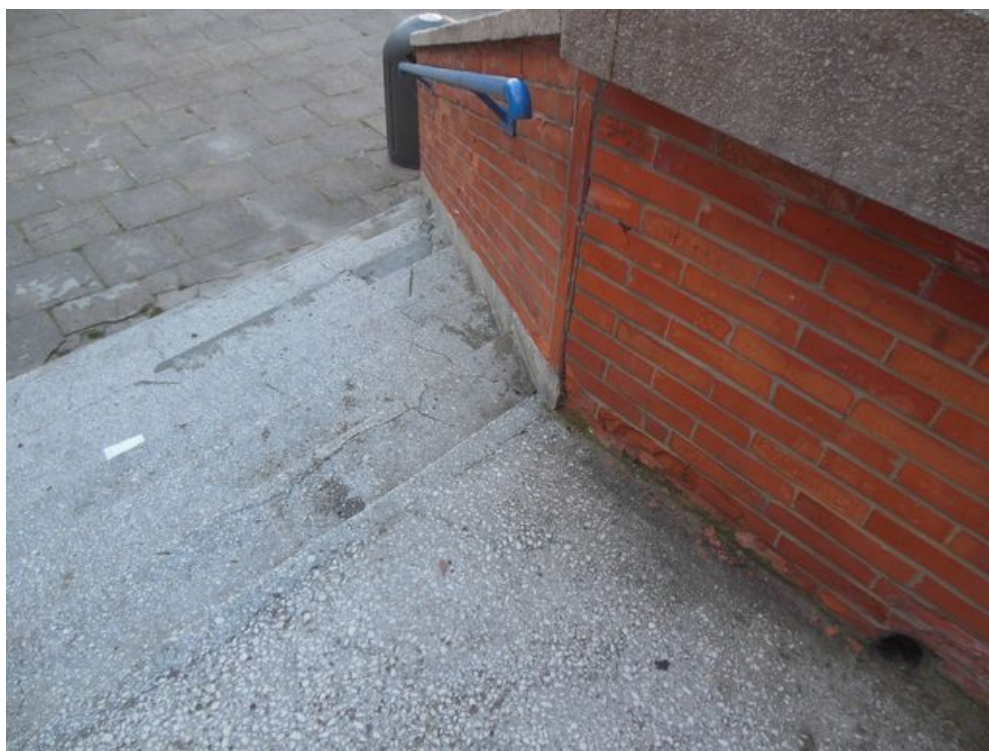
Zdjęcie nr 20 – Uszkodzony fragment ściany i bieg schodowy głównego wejścia do szkoły
