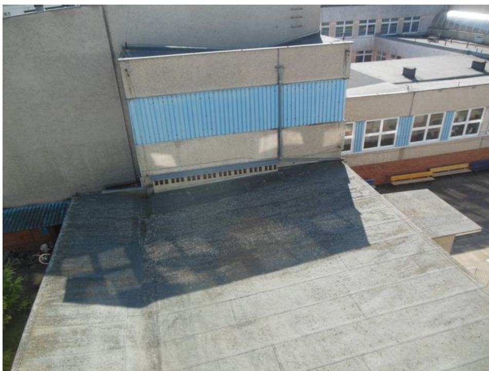
Zdjęcie nr 22 – Widok pokrycia dachu nad łącznikiem. Papa bardzo wyeksploatowana.
