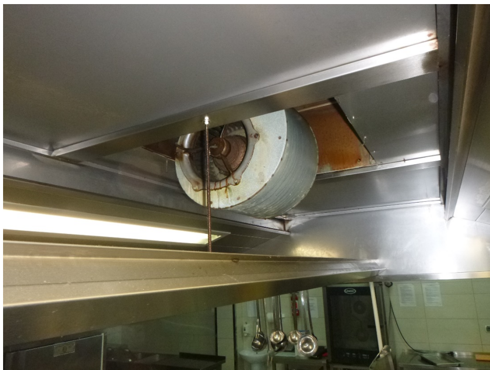
fot 60 Układ W5 – okap wywiewny Ok1, Zdemontowane filtry. Uszkodzenie wentylatora i zatłuszczenie i korozja wnętrza kanału
