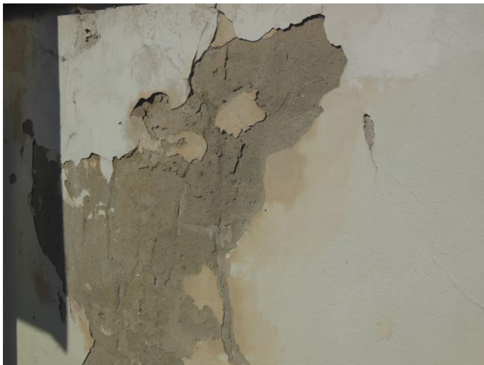
Zdjęcie nr 15 – Zniszczony fragment tynku na ścianie ośrodka sportowego
