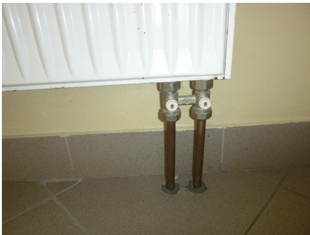
fot 18 Zasilenie grzejnika instalacja miedziana
