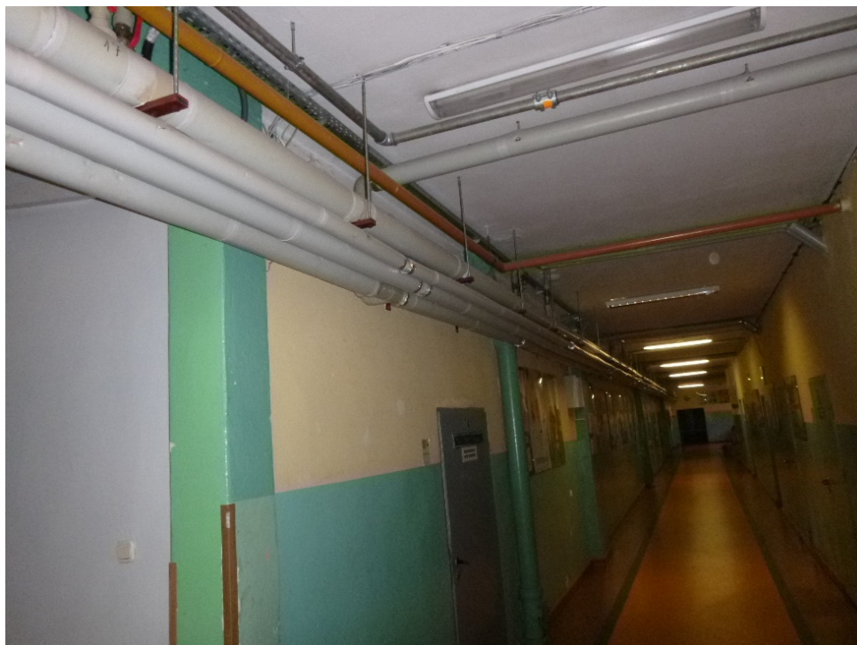
fot 17 Poziom c.o. w piwnicy i pod stropem (prowadzony nad poziomami wody użytkowej)
