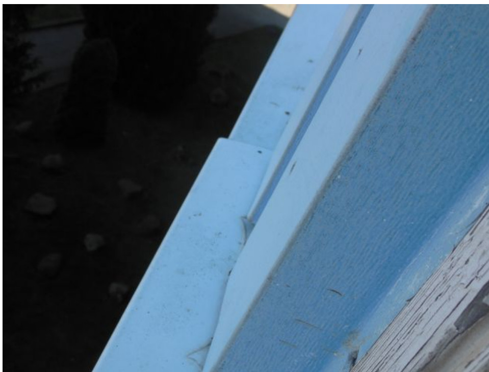
Zdjęcie nr 18 – Wadliwie zamocowany parapet zewnętrzny
