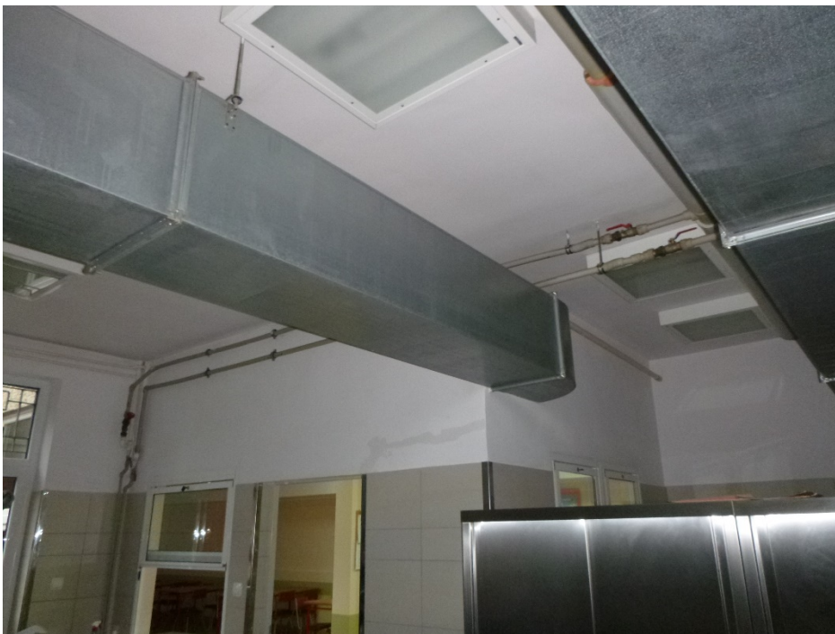
fot 53 Układ NW4. Kanały pod stropem pomieszczeń kuchni. Kanały bez izolacji i zabudowy.
