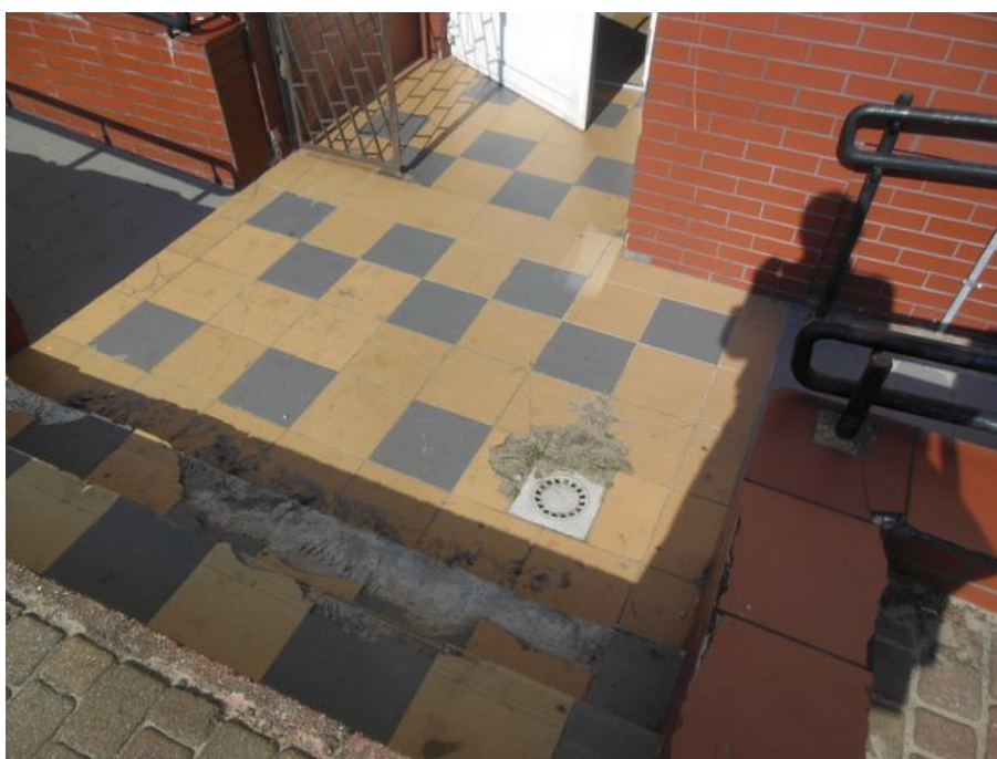
Zdjęcie nr 10 – Zniszczenia płytek podłogowych i murków przyschodowych i wejście dla inwalidów przy wejściu do ośrodka sportowego
