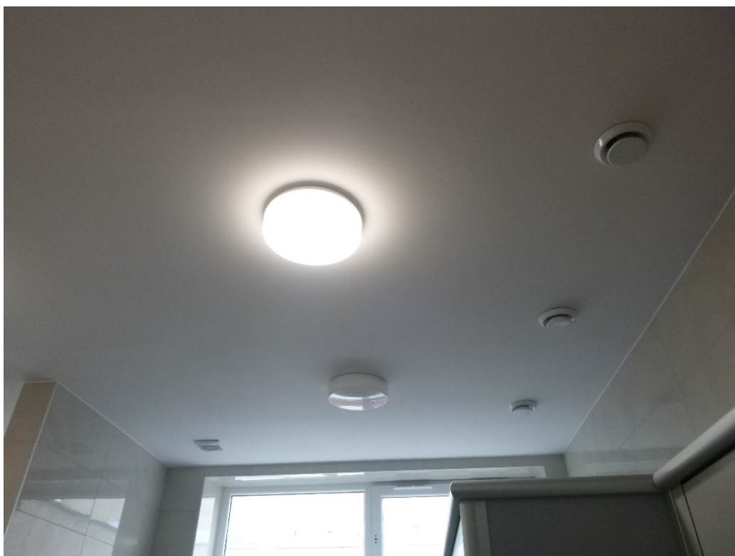
fot 46 Układ wywiewny natryski segment C. Anemostaty wywiewne i wentylatory sufitowe.
