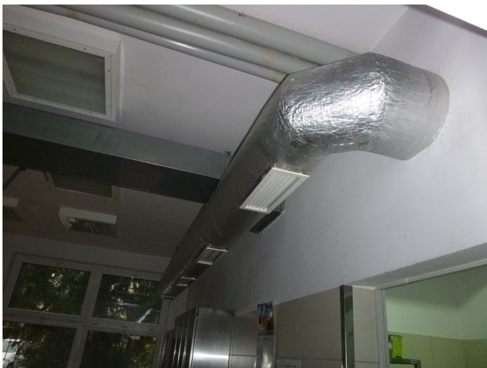
fot 58 Układ N5, W5 – kanały nawiewne do kuchni (izolowane) i wywiewne z okapu.
