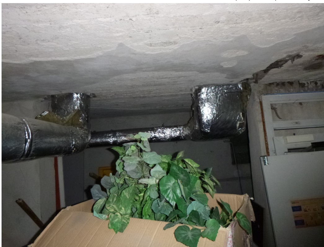
fot 42 Układ NW2. Uszkodzona izolacja kanału w pomieszczeniach nieogrzewanych przy patio
