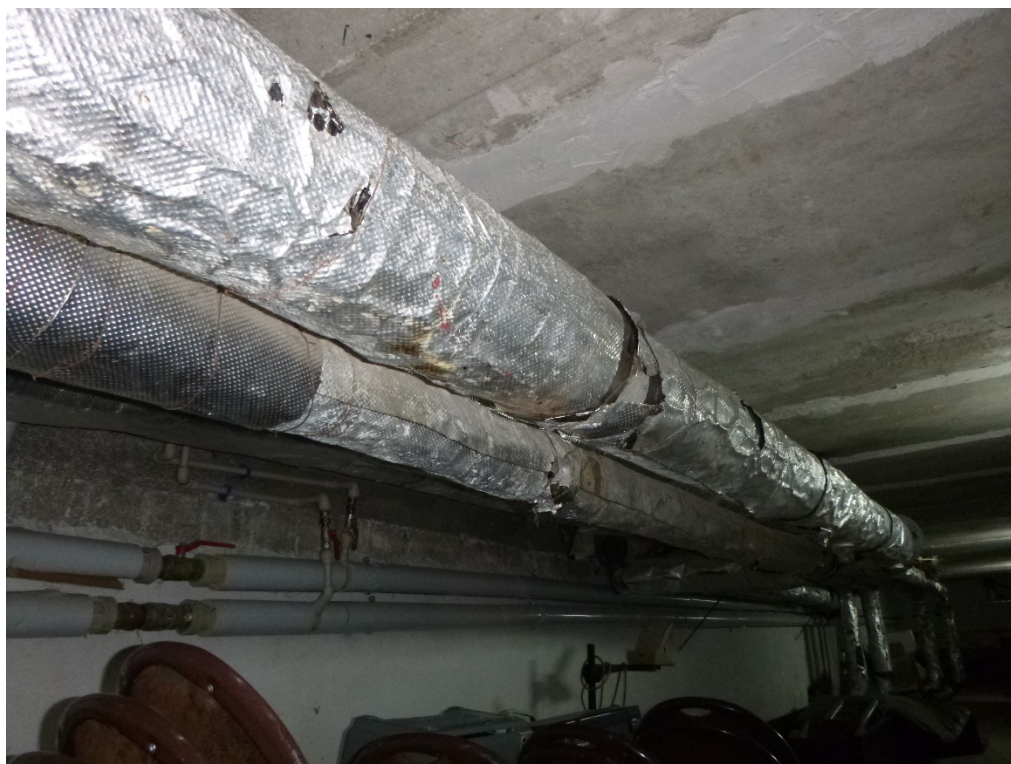
fot 28 Poziom instalacji c.t., c.o., wodnej na zasileniu z węzła ciepłowniczego (korytarz techniczny pod łącznikiem)
