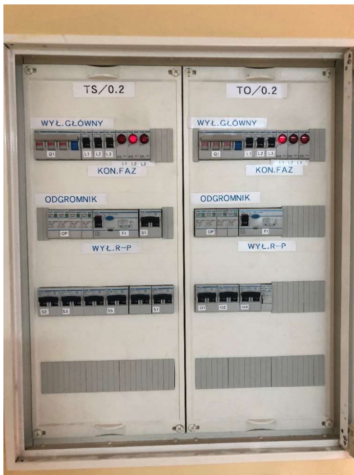
Zdjęcie nr 3 – tablica rozdzielcza w ukł. TN-S w segmencie „A”
