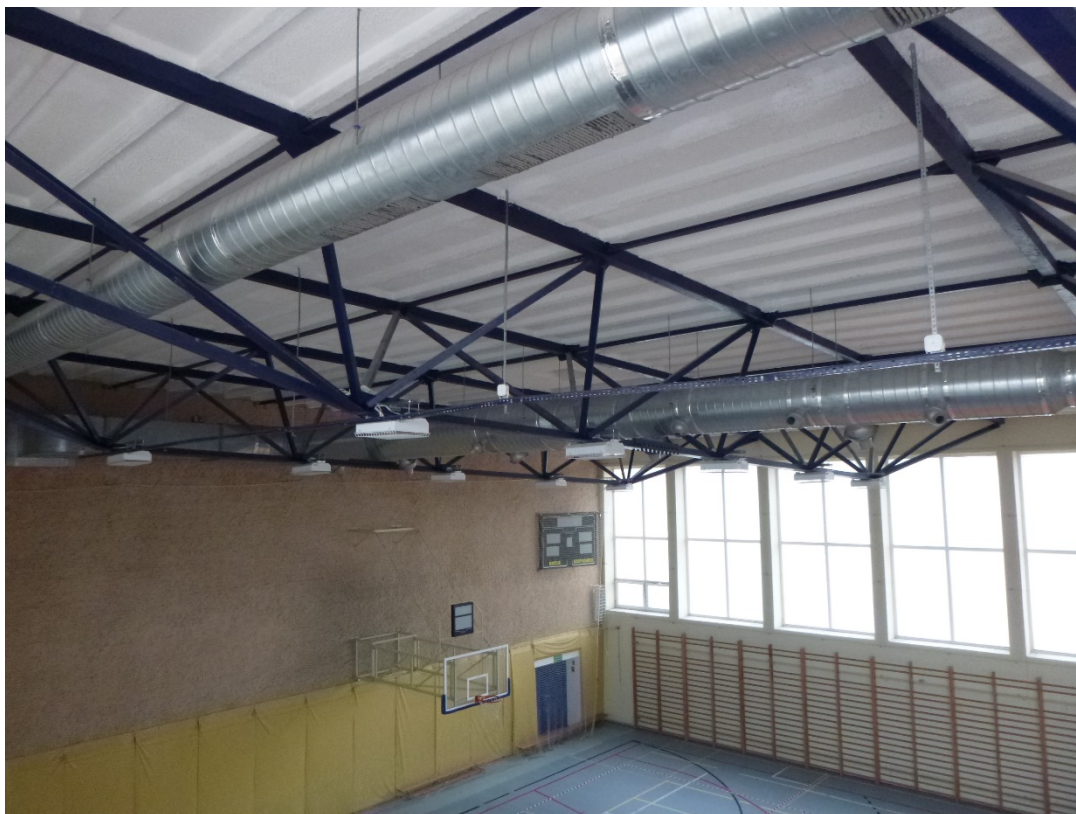
fot 35 Układ NW1. Hala sportowa. Kanały w hali. Brak izolacji i części dysz nawiewnych.
