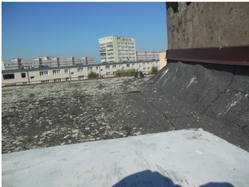
Zdjęcie nr 23 – Pokrycie dachu nad budynkiem dydaktycznym. Papa bardzo wyeksploatowana.
