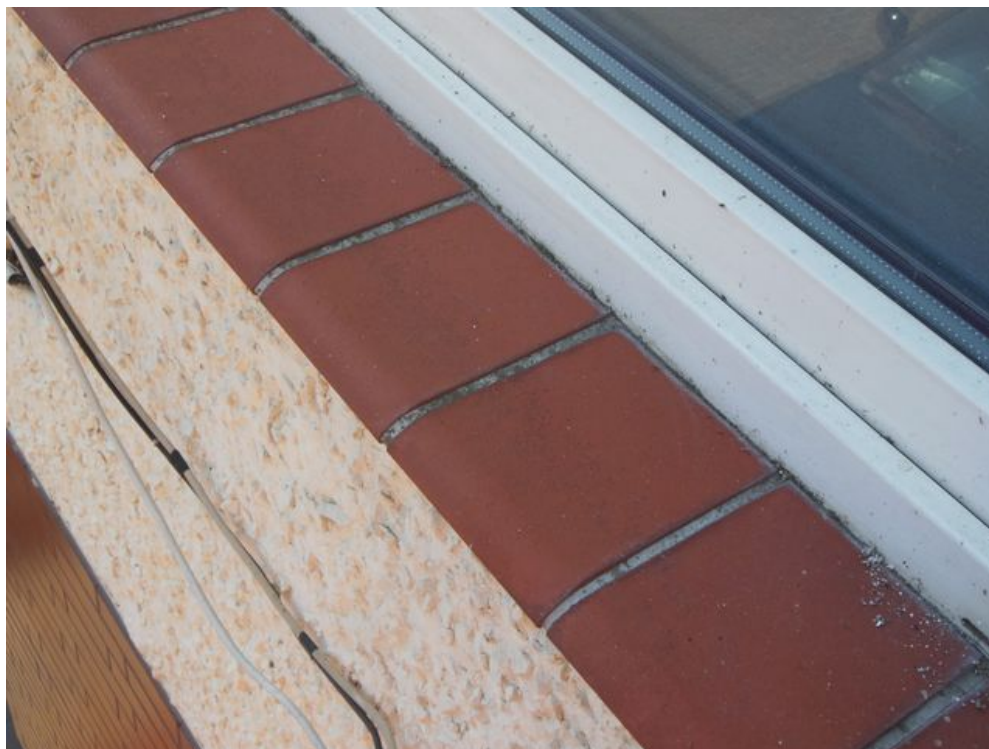
Zdjęcie nr 19 – Płytki parapetowe są za wąskie
