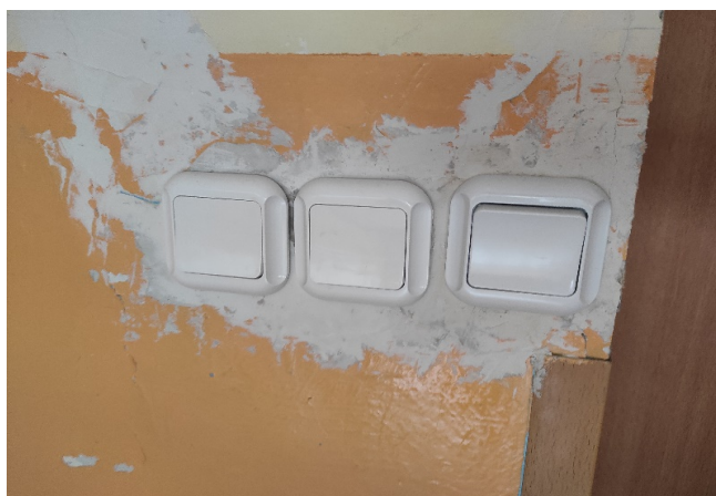
Zdjęcie nr 9 i 10 – istniejąca instalacja oświetleniowa – łączniki oświetleniowe
