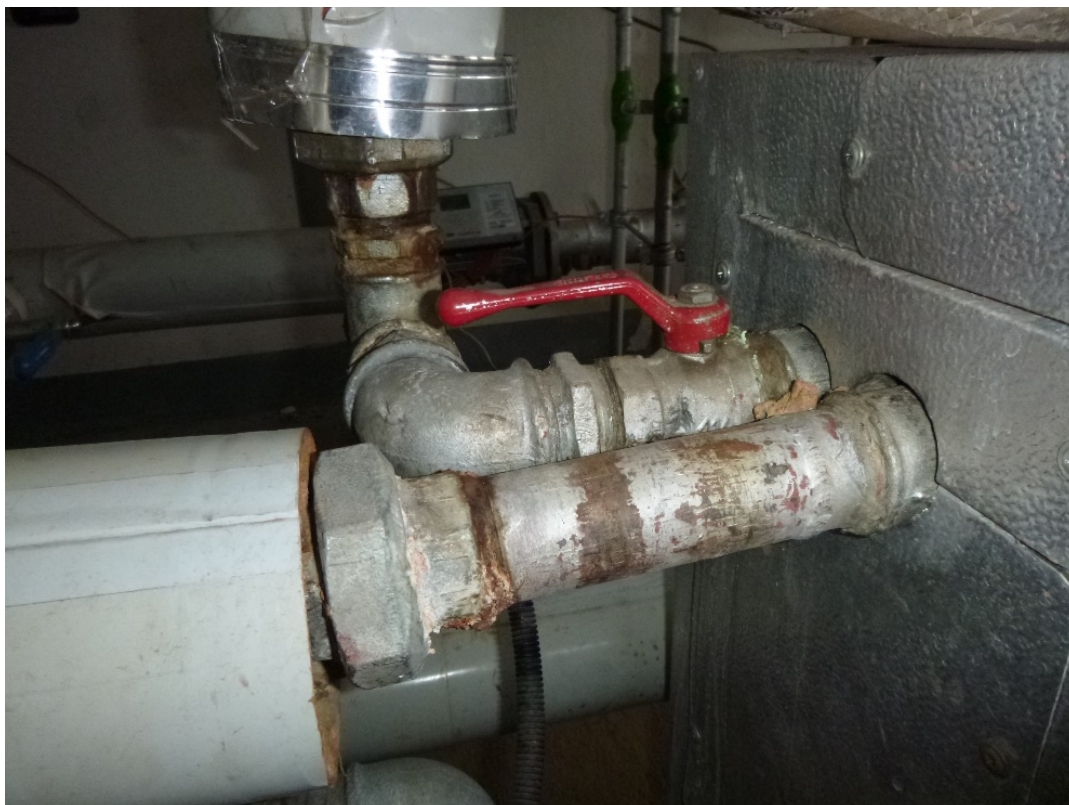
fot 30 Lokalne przecieki z widocznym osadzeniem kamienia i korozją
