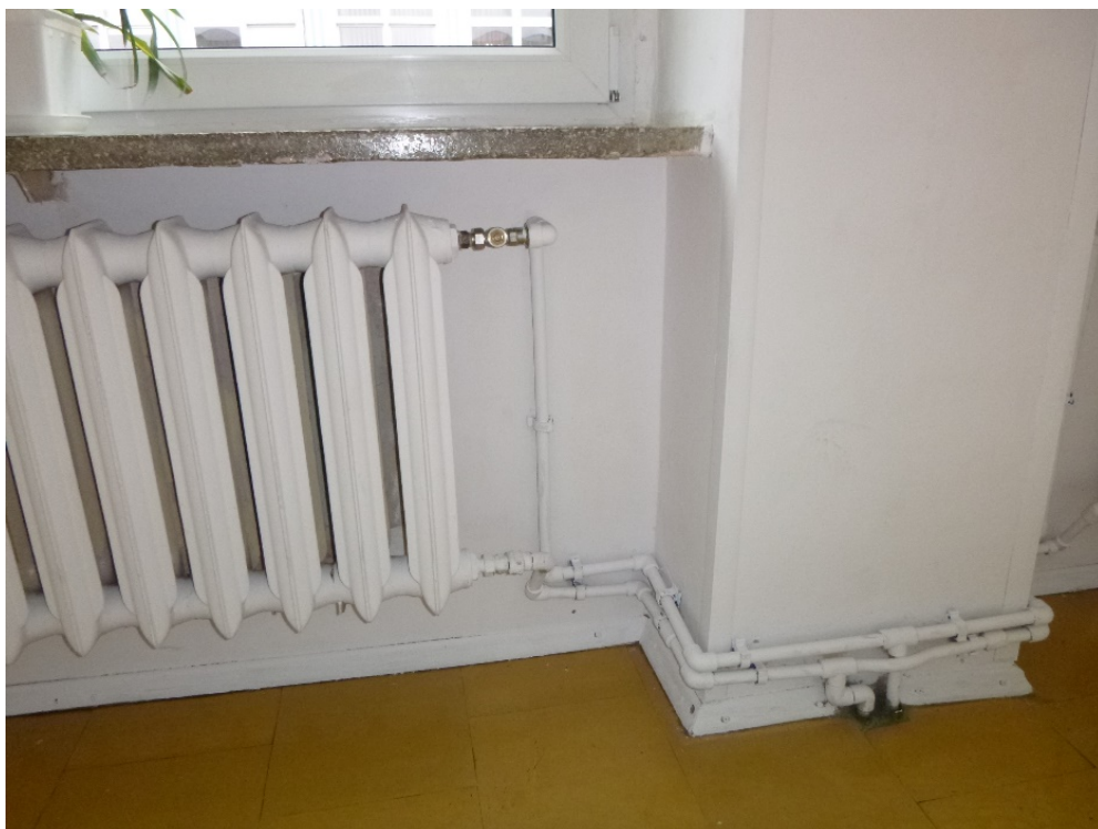
fot 20 Zasilenie grzejnika instalacja PP
