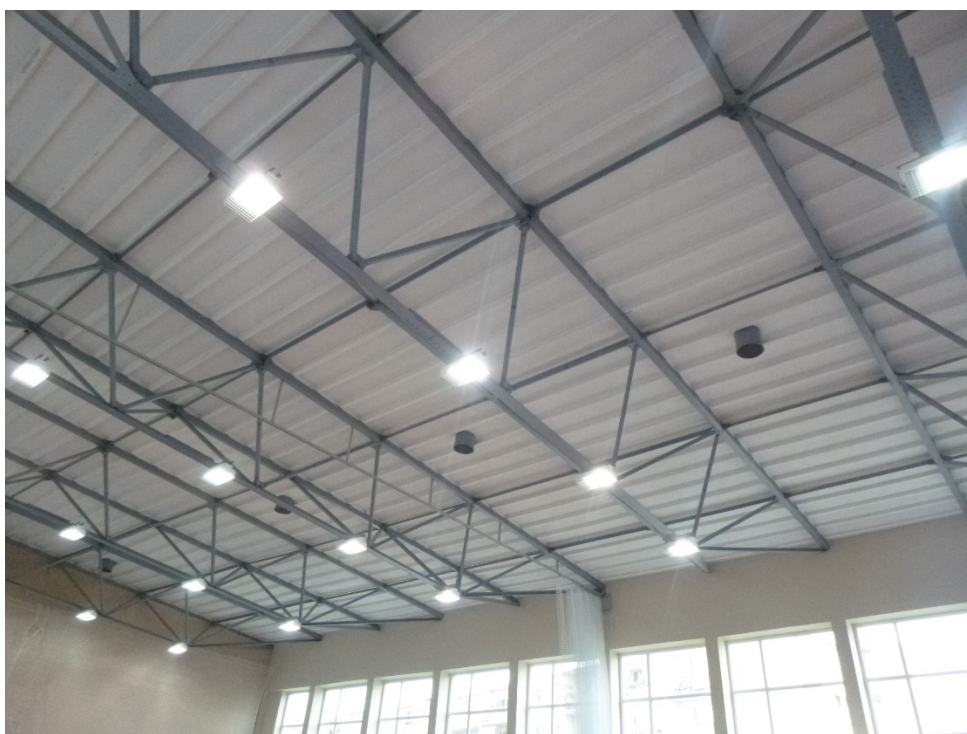
fot 49 Układ wywiewny sali segment C. Wloty do wywietrzaków.
