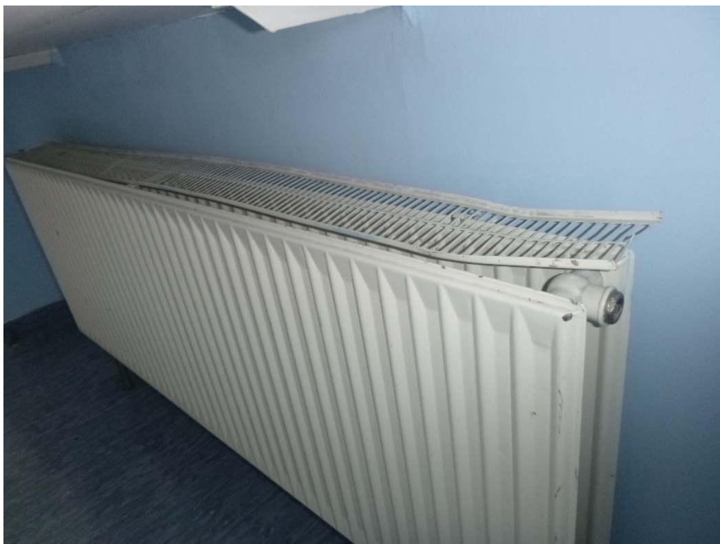
fot 24 Uszkodzenia grzejników oraz braki w armaturze regulacyjnej
