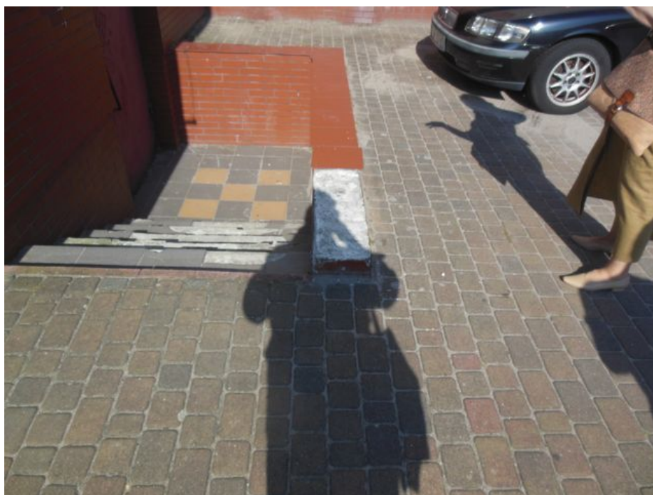
Zdjęcie nr 12 – Zniszczone płytki biegu schodowego oraz murki przy wejściu do piwnicy ośrodka sportowego
