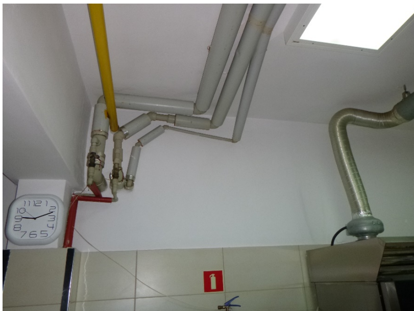
fot 3 poziom wody zimnej, ciepłej i cyrkulacji pod stropem kuchni
