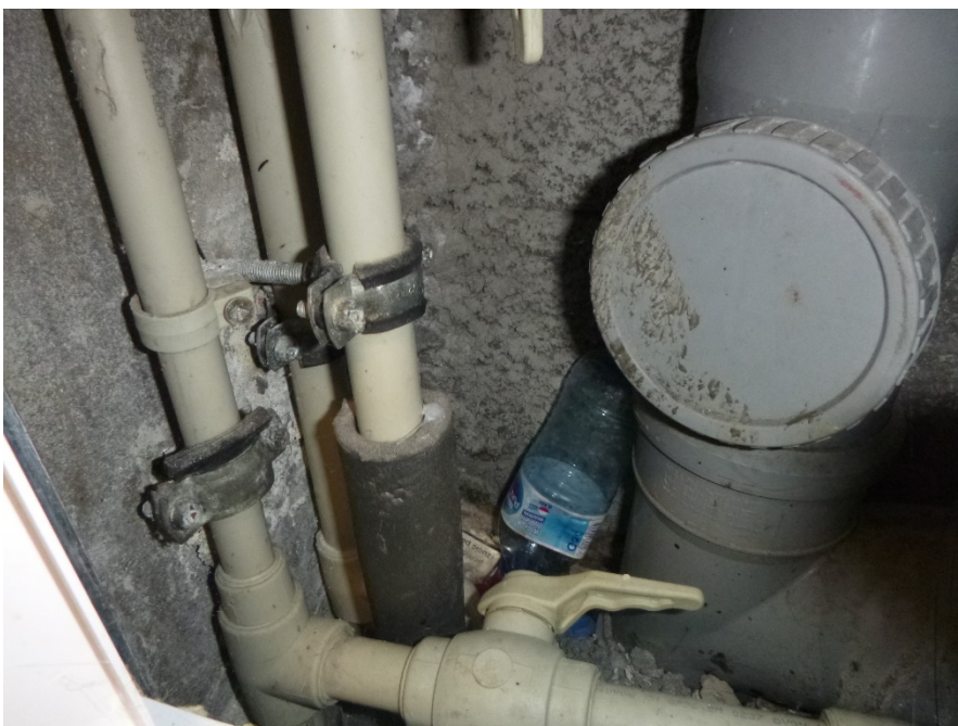
Fot 12 Instalacja w szachcie sanitariatów przy hali sportowej (segment B). Braki częściowy izolacji instalacji
