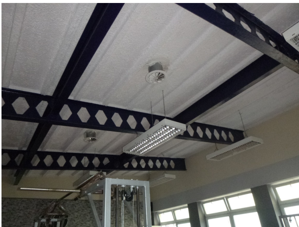
fot 51 Układ wywiewny Sali siłowni segment C. Wentylacja mechaniczna
