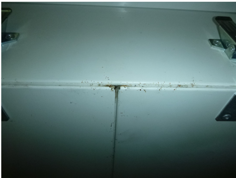
fot 57 Układ N5 - centrala nawiewna w wentylatorni. Widoczne ślady korozji na spodzie centrali.
