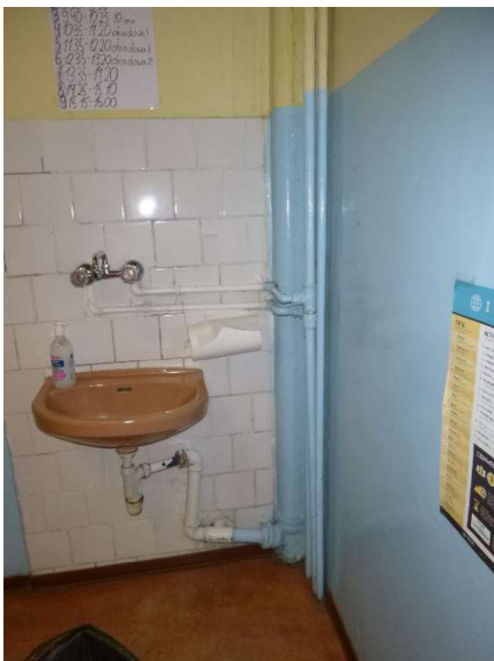
fot 4 podejście i pion instalacji wodnej w obrębie piwnic
