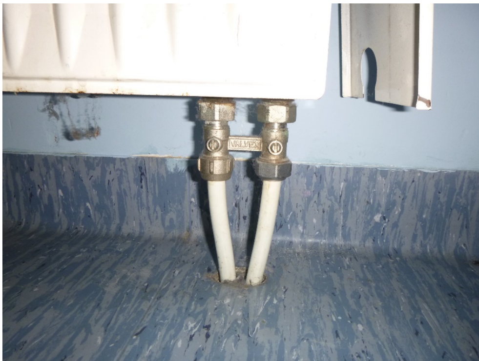
fot 19 Zasilenie grzejnika instalacja PE
