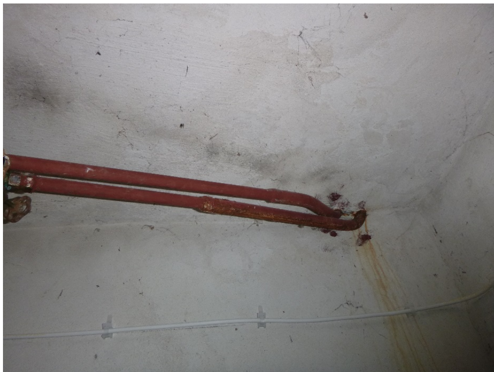
fot 21 Zasilenie grzejnika instalacja stalowa spawana
