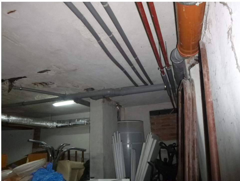
fot 23 Instalacja zasilenia w pom. nieogrzewanych przy patio (brak izolacji na przewodach stalowych)
