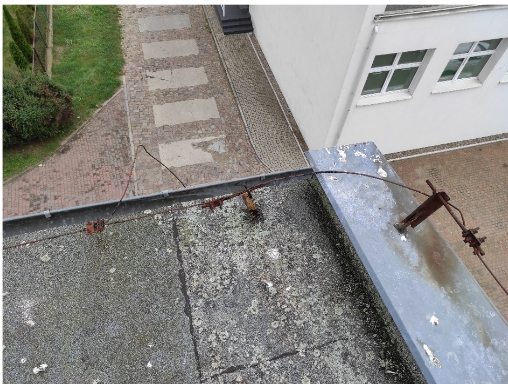
Zdjęcie nr 14 – istniejąca instalacja odgromowa – zwody poziome
