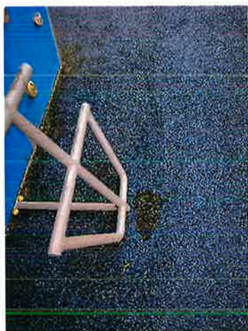
4. Wytarcie nawierzchni przy drabince wejściowej na zestaw zabawowy „statek piracki”
