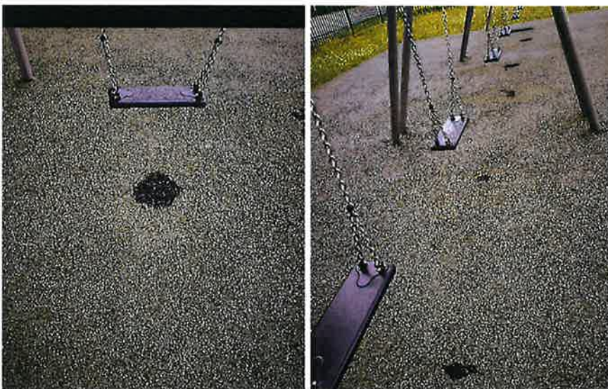
2. Wytarcia nawierzchni przy huśtawkach
