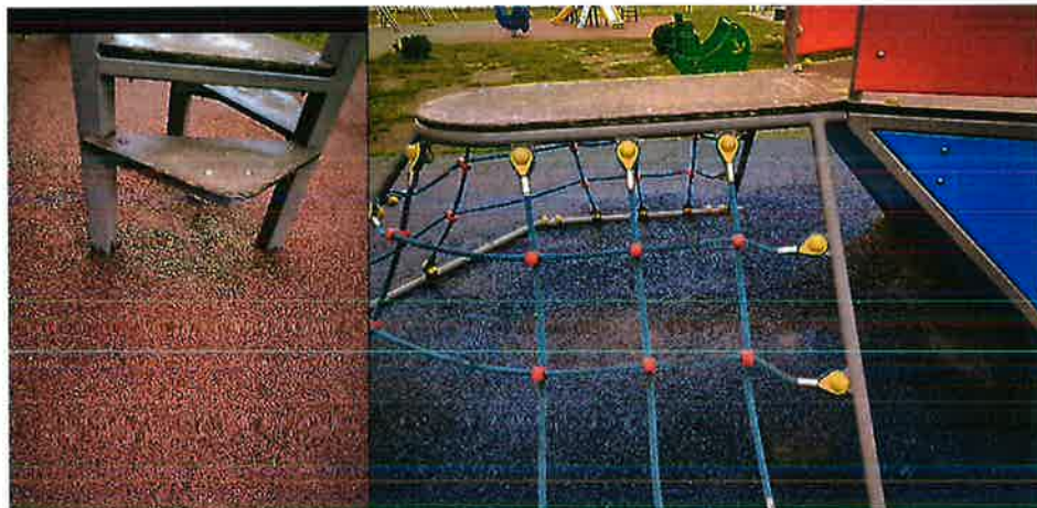
3. Zapadnięcia nawierzchni przy zabawkach
