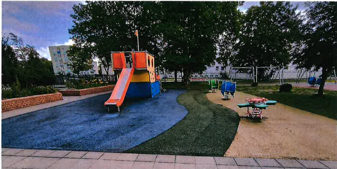
Widok na pęknięcia nawierzchni na łączeniach i na powierzchni
