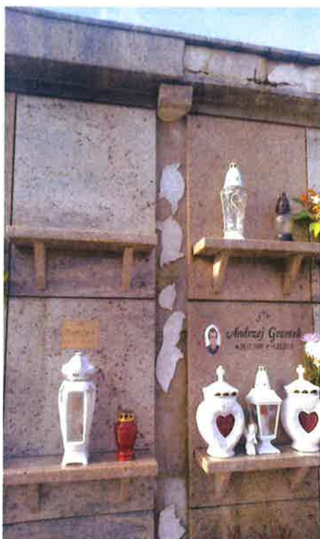
Fot.1,2. Widok ścian kolumbarium z ubytkami.
