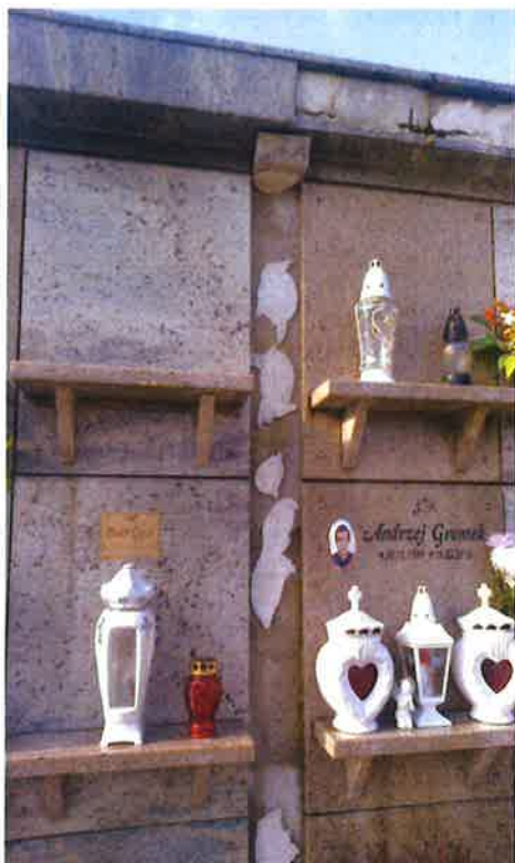
Fot.1,2. Widok ścian kolumbarium z ubytkami.
