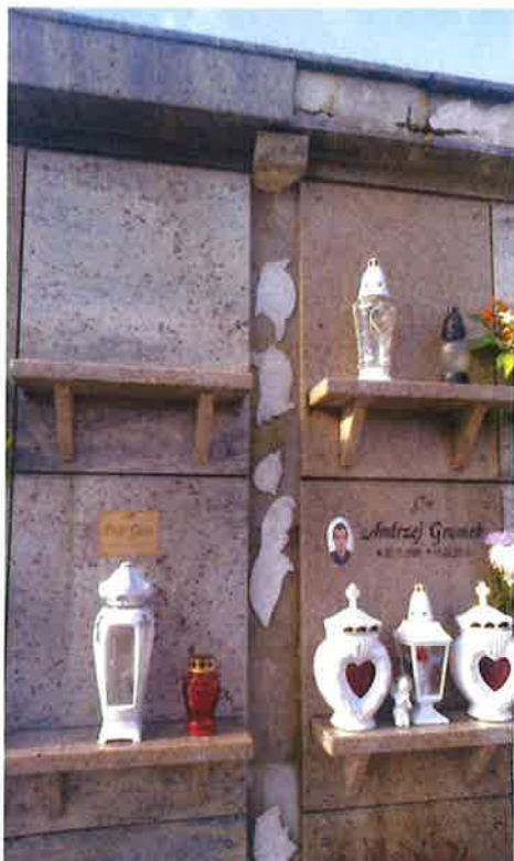
Fot.1,2. Widok ścian kolumbarium z ubytkami.
