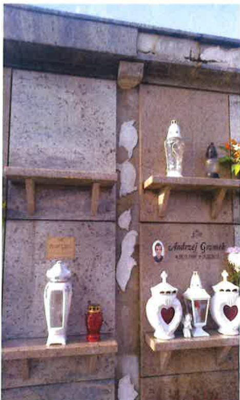
Fot.1,2. Widok ścian kolumbarium z ubytkami.
