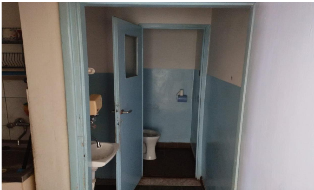
Toaleta wraz z pomieszczeniem socjalnym, znajdującym się na parterze.
