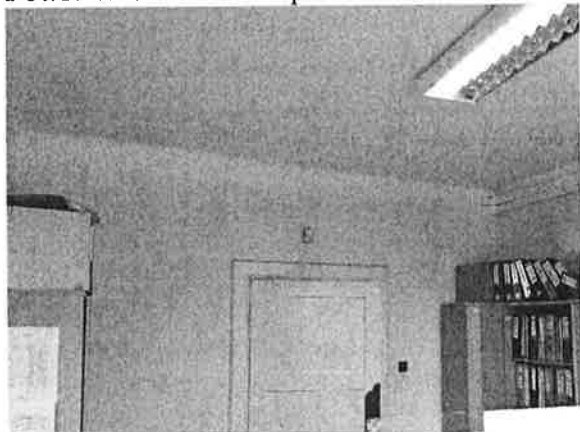
Fot.2. Widok na ściany pomieszczenia biurowego
