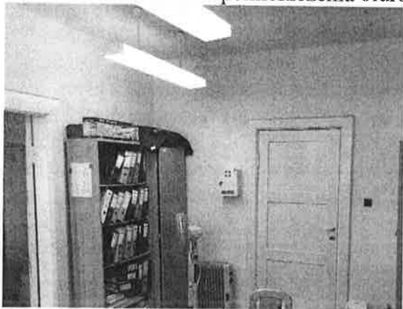
Fot. 12. Widok na ściany pomieszczenia biurowego
