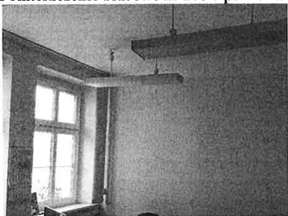
Fot. 13. Widok na sufit pomieszczenia biurowego
