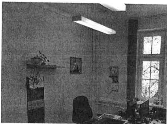
Fot. 11. Widok na sufit pomieszczenia biurowego
