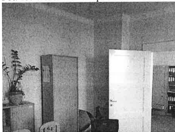
Fot. 14. Widok na ściany pomieszczenia biurowego
