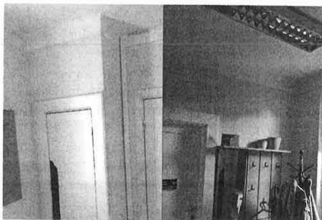
Fot. 7-8. Widok na ściany przedsionka
