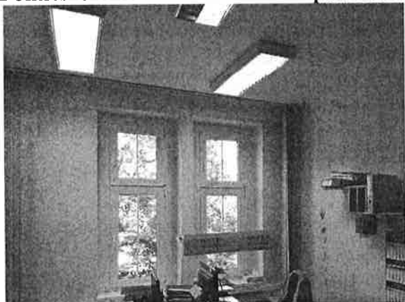
Fot.1. Widok na sufit pomieszczenia biurowego
