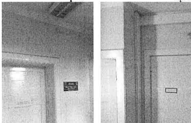
Fot. 14. Widok na ściany przedsionka
