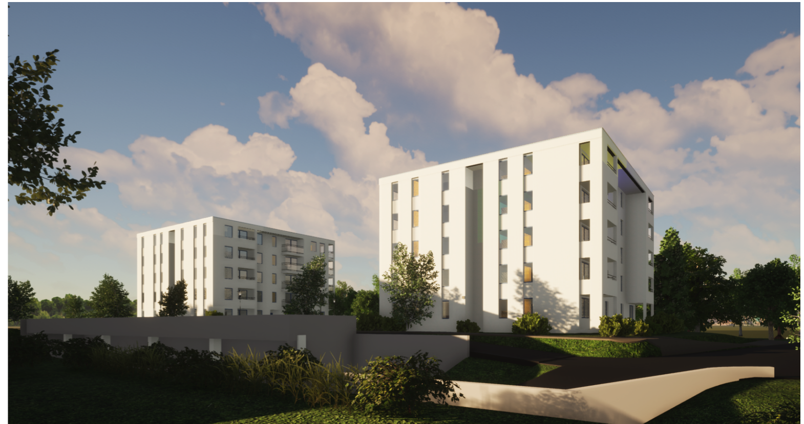
WIDOK 2 OD STRONY PÓŁNOCNO-ZACHODNIEJ
