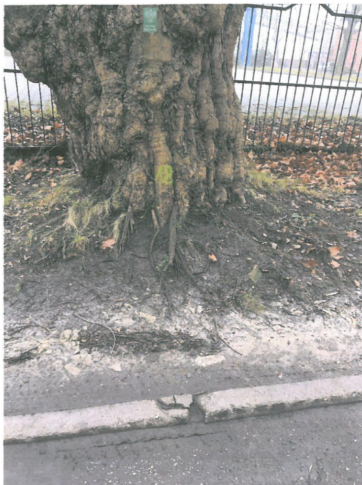
Fot. 5. Widoczne odsłonięte korzenie
