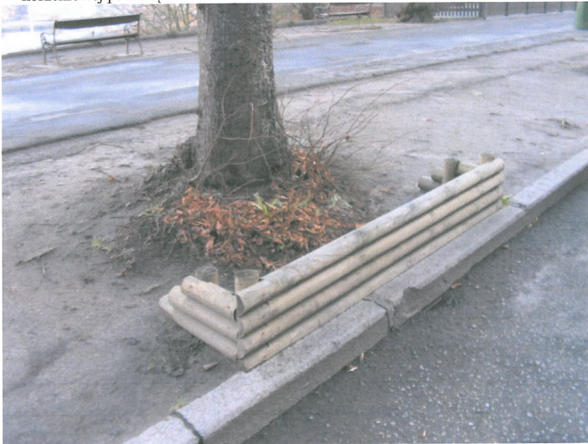
Fot. 8. Przykładowe rozwiązanie zabezpieczenia nasady pnia i strefy korzeniowej palisadą
