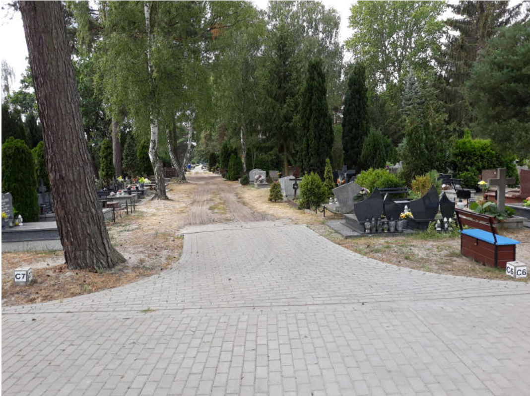
Rys. 4. Punkt G i H - przykład sposobu wykonania nawierzchni na połączeniu nowej nawierzchni i drogi gruntowej (patrz: mapa)
