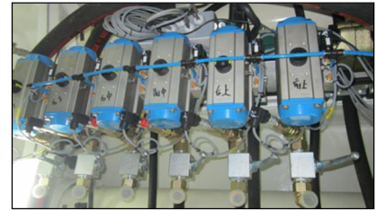
Rys. 2-14 Zawory rozdzielcze smaru do uszczelnienia ogona
