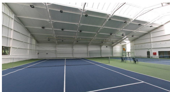
Rysunek 8. Hala tenisowa o nawierzchni twardej przy ulicy Matejki
