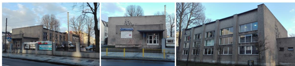
Rysunek 12. Sala gimnastyczna przy ulicy Piłsudskiego
