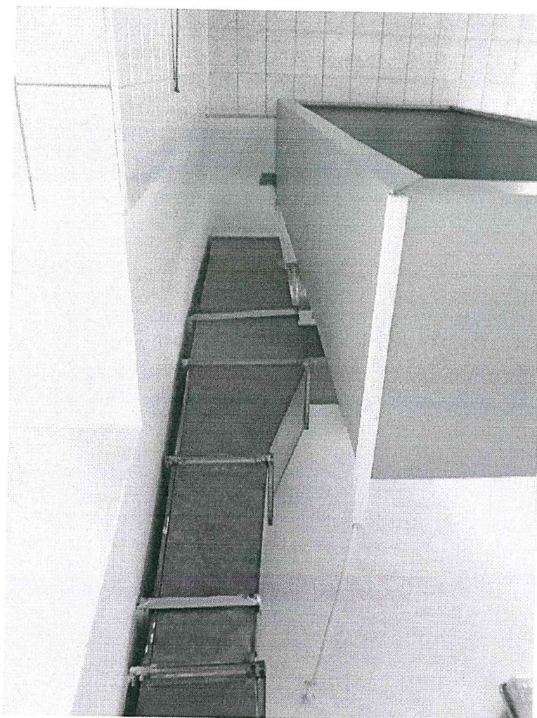
Zdjęcie 7. Kanał wyciągowy – widok w kierunku pionu.
