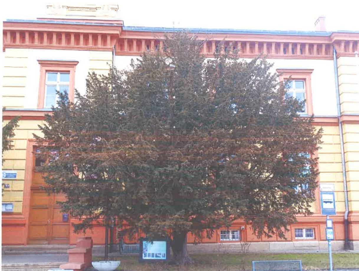
Fot. 2. Drzewo nr 1 – widoczne suchoczuby oraz posusz gałęziowy
