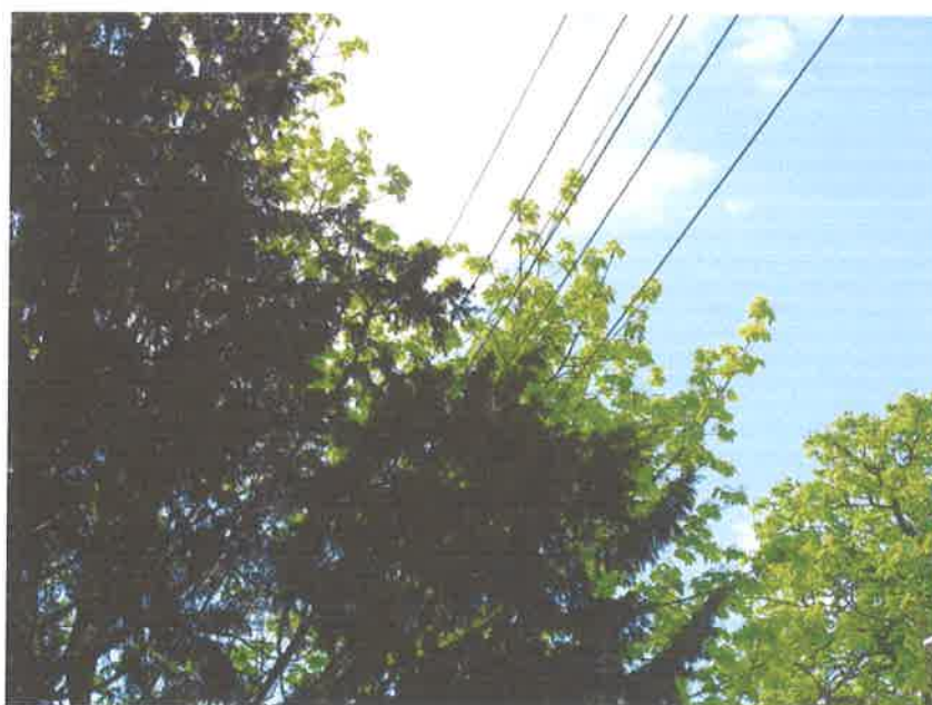
Fot. 2. Kolizja z linią energetyczną
