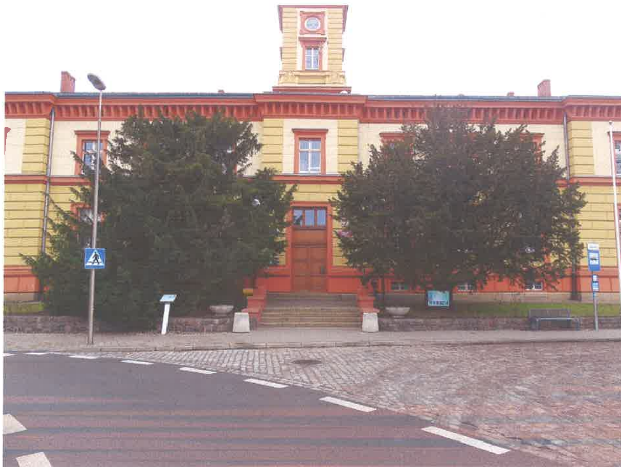
Fot. 1. Widok ogólny na drzewa. Kolizja z infrastrukturą miejską
