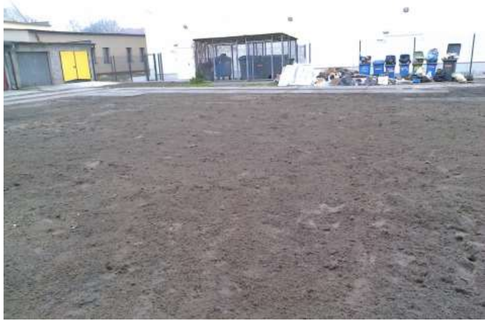
Stan po dokonaniu rozbiórki
