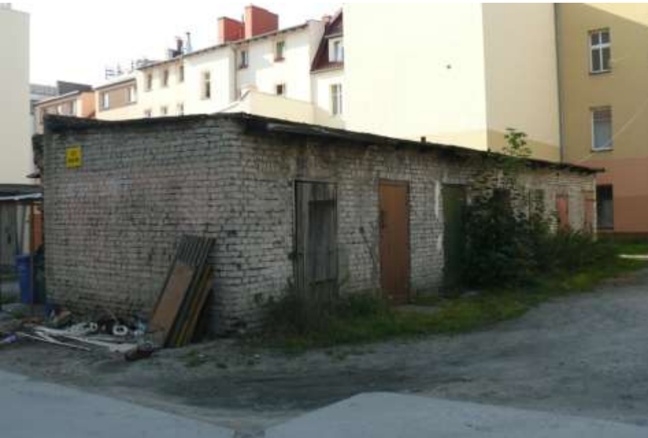
Stan przed rozbiórką
