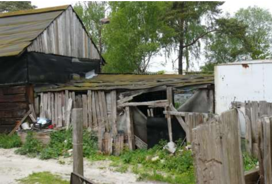
Stan przed rozbiórką
