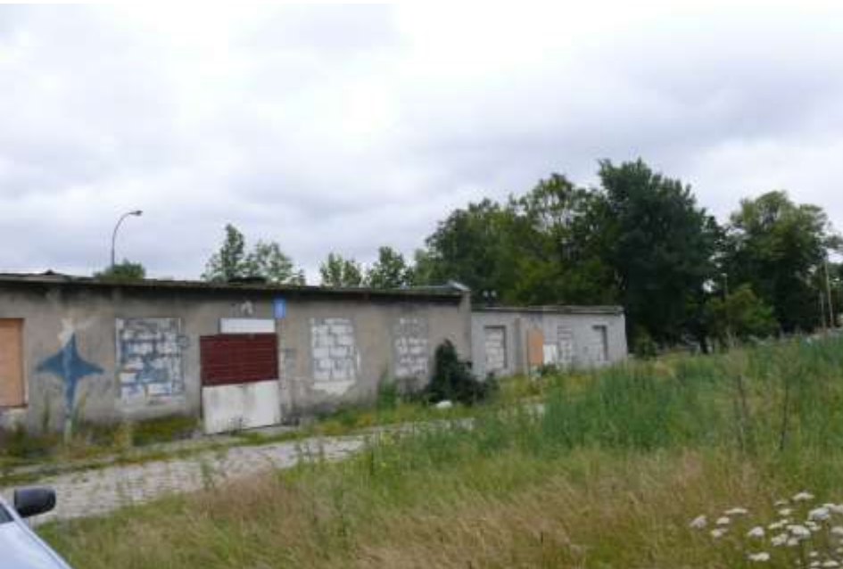
Stan przed rozbiórką
