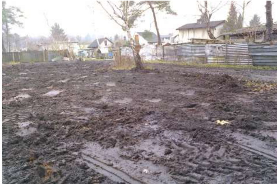
Stan po dokonaniu rozbiórki
