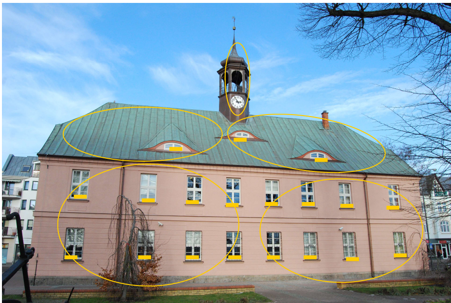
52 opraw liniowych LED , RGB 16 opraw projektorowych LED
