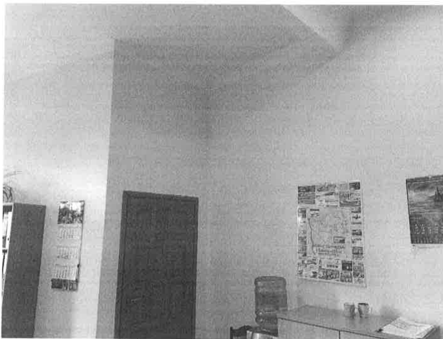
Fot.1. Widok na ściankę do rozebrania
