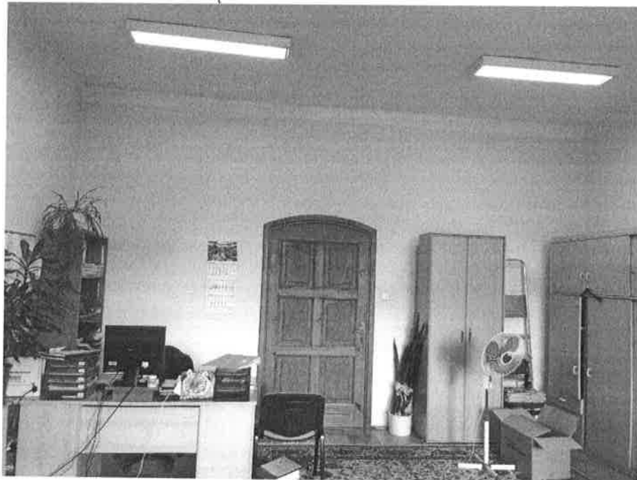
Fot.2. Widok na sufit pomieszczenia biurowego.
