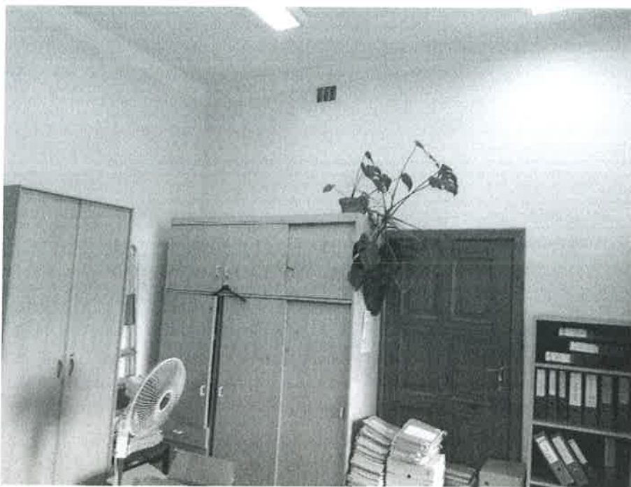
Fot.3. Widok na ściany pomieszczenia biurowego
