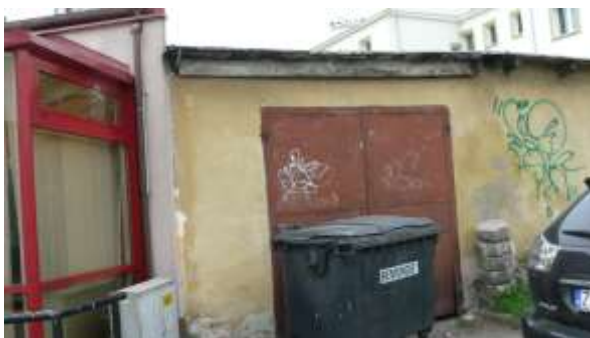
Fot. 17. Garaż do pozostawienia.
