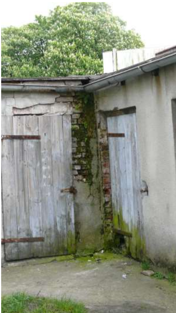
Fot. 19. Miejsce granicy rozbiórki komórek.
