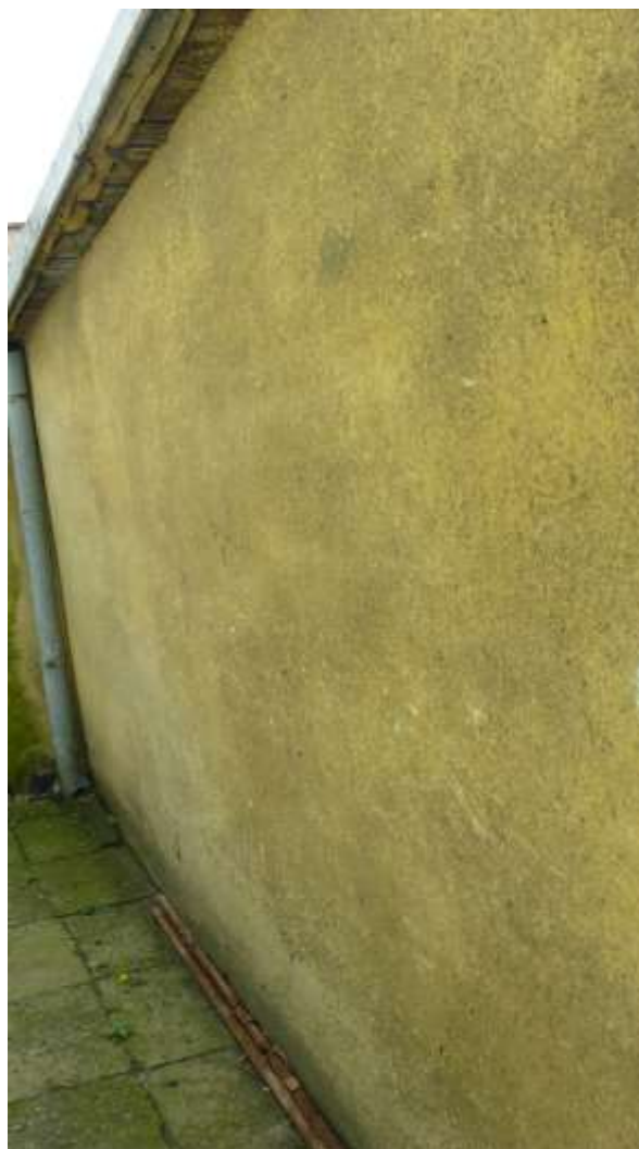
Fot. 20. Elewacja boczna przy budynku mieszkalnym.
