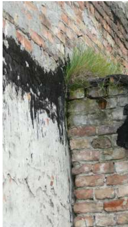
Fot. 9-10. Widok łączenia rozbieranych budynków gospodarczych z istniejącym murem ogrodzenia.
