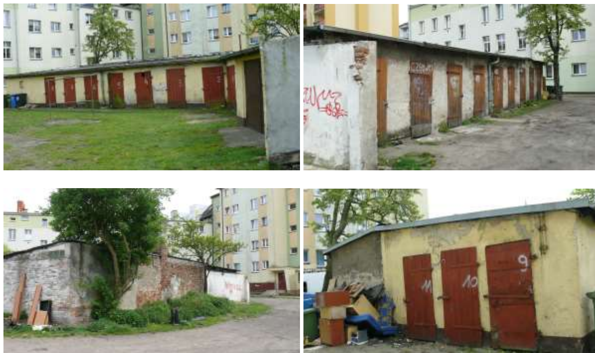
Fot.1-4. Widok komórek gospodarczych do rozbiórki.
