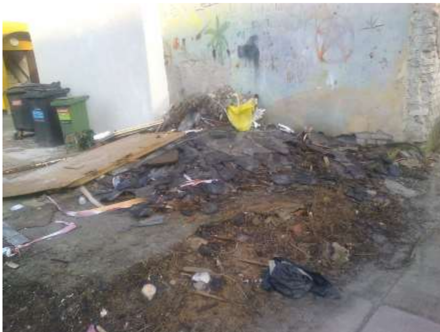
Fot. 21. Miejsce rozbiórki i uporządkowania terenu.
