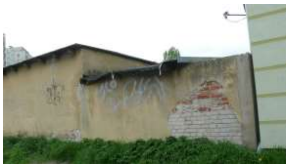
Fot. 18. Ściana tylna na łączeniu z budynkiem mieszkalnym.
