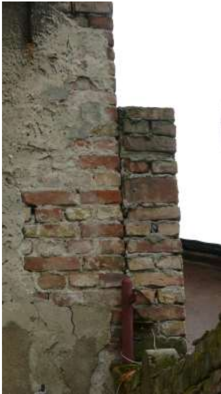
Fot. 9-10. Widok łączenia rozbieranych budynków gospodarczych z istniejącym murem ogrodzenia.
