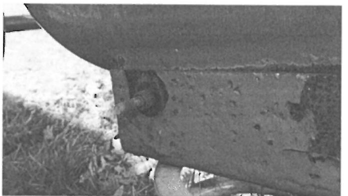
Brak zaślepek z tworzywa sztucznego - sześciokąt wielofunkcyjny, piramida metalowa ze ścianką wspinaczkową, bujak sprężynowy. Zaleca się uzupełnienie.
