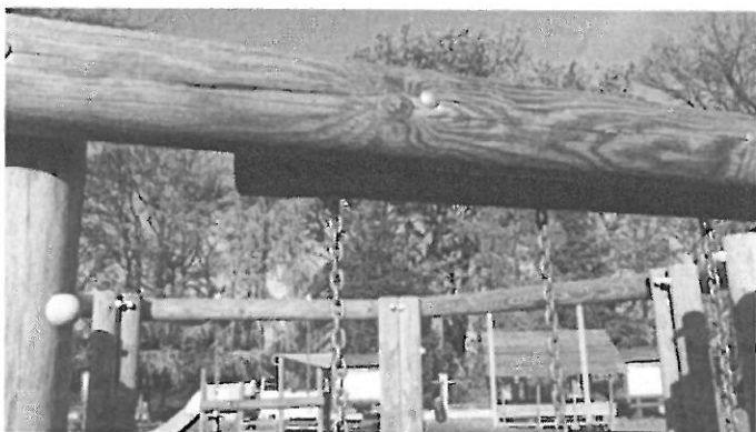
Znaczny rozkład poziomych elementów drewnianych sześciokąta wielofunkcyjnego. Zaleca się wymianę wszystkich drewnianych elementów poziomych.
