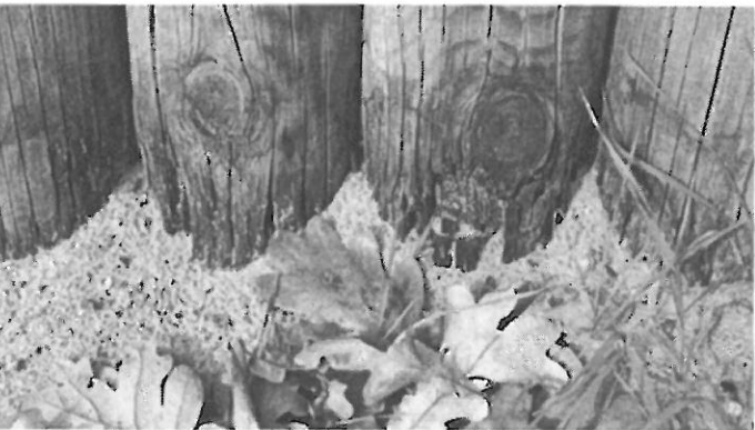
Znaczny rozkład elementów piaskownicy z palisady. Zaleca się wymianę piaskownicy.
