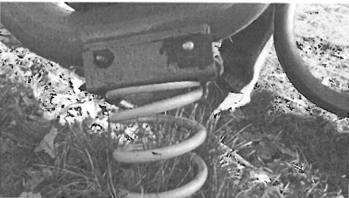
Luzy w połączeniu górnej części bujaka ze sprężyną, luzy w połączeniu belki drewnianej z podstawą metalową w huśtawce ważce. Zaleca się naprawę.
