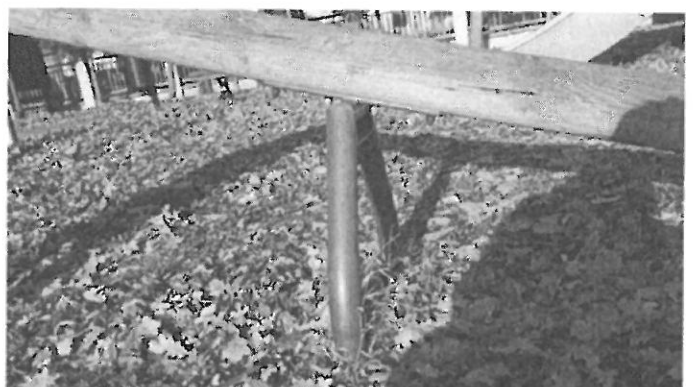
Luzy w połączeniu górnej części bujaka ze sprężyną, luzy w połączeniu belki drewnianej z podstawą metalową w huśtawce ważce. Zaleca się naprawę.
