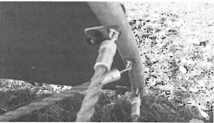
Brak zaślepek z tworzywa sztucznego - sześciokąt wielofunkcyjny, piramida metalowa ze ścianką wspinaczkową, bujak sprężynowy. Zaleca się uzupełnienie.
