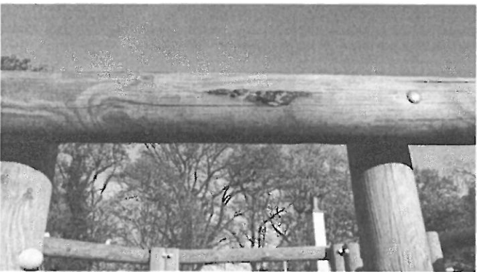
Znaczny rozkład poziomych elementów drewnianych sześciokąta wielofunkcyjnego. Zaleca się wymianę wszystkich drewnianych elementów poziomych.
