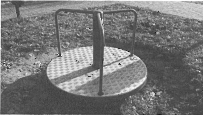
Nadmierne luzy w mechanizmie karuzeli. Zaleca się naprawę.
