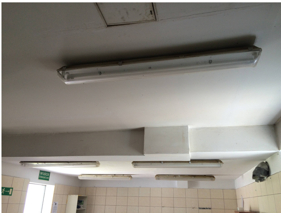
Fot 3. Widok sufitu i ścian kuchni
