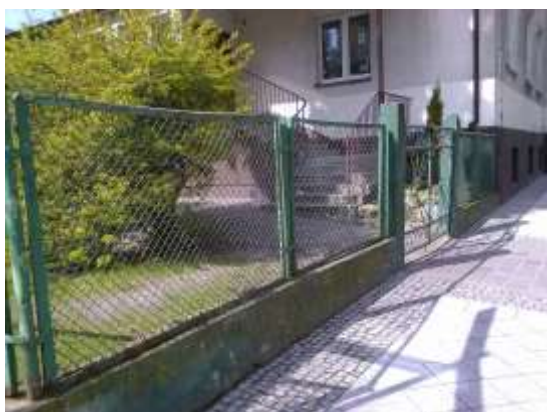
Fot. 1 Fragment ogrodzenia do rozbiórki.
