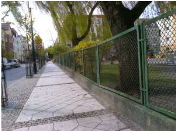
Fot.6. Odcinek do demontażu i wymiany.
