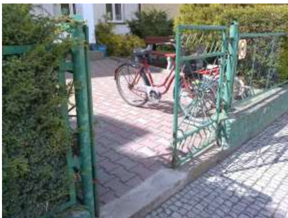
Fot. 4. Furtka do demontażu i wymiany.
