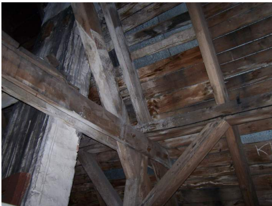
Fotografia nr 19 – Strych równoległy do ul. Mar. Józefa Piłsudskiego. Na fotografii widoczne jest silne zagrzybienie wywołane przez grzyby domowe Serpula Lacrymans . Zagrzybienie powstało na skutek nieszczelności wokół komina nr 2.
