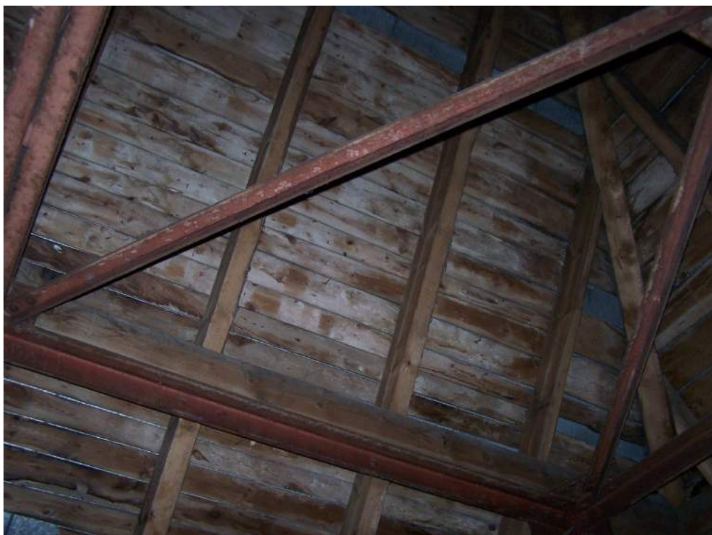
Fotografia nr 11 – Więźba dachowa usztywniona stalową ramą. Fotografia przedstawia widok w kierunku górnej południowej połaci dachu. Deskowanie na tej połaci pokryte jest białym, cienkim nalotem wywołanym przez grzyby domowe Serpula Lacrymans .
