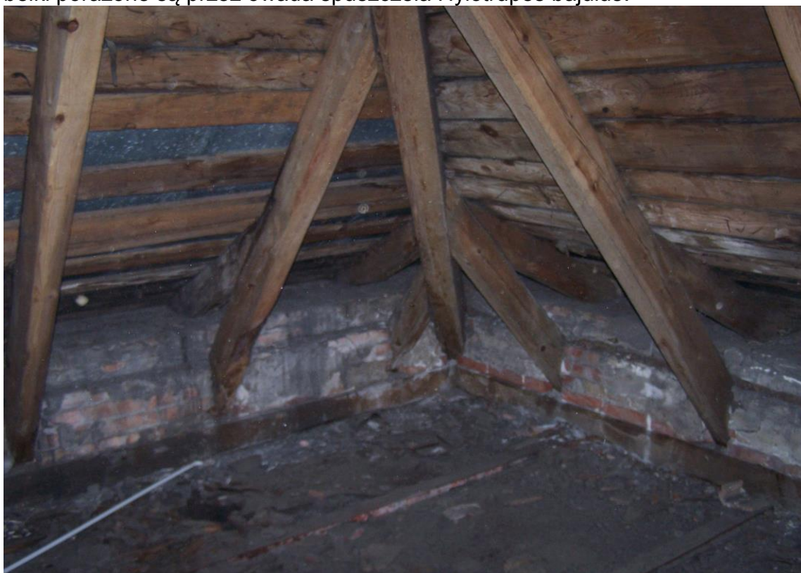
Fotografia nr 15 – Więźba dachowa usztywniona stalową ramą. Południowo wschodnie belki porażone są przez owada spuszczała Hylotrupes bajulus .
