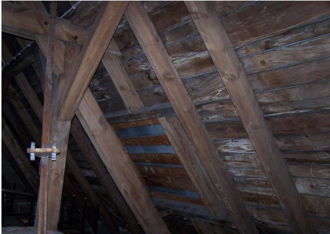
Fotografia nr 21 – Strych równoległy do ul. Mar. Józefa Piłsudskiego. Zagrzybione deskowanie na wschodniej połaci w części środkowej. zagrzybienie wywołane przez grzyby domowe Serpula Lacrymans .
