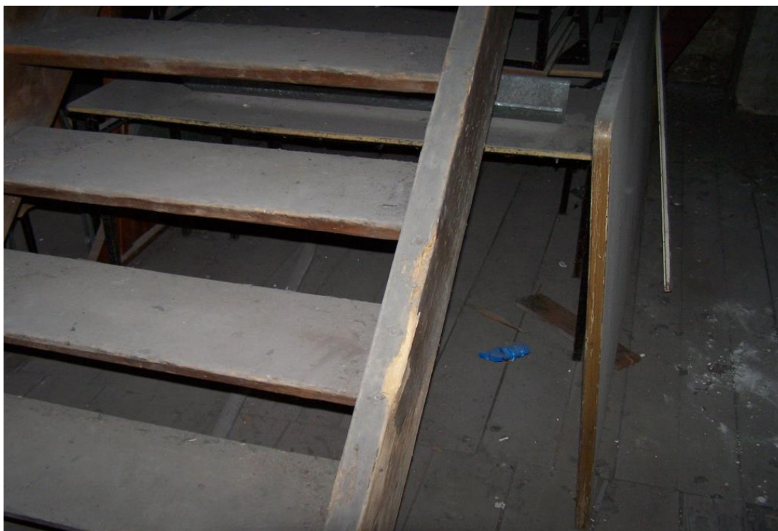
Fotografia nr 7 – Prawy policzek schodów, równoległy do ul. Gabriela Narutowicza jest mocno zaatakowany przez owada kołatka domowego Anobium punctatum . Należy wymienić prawy policzek i słupki balustrad.
