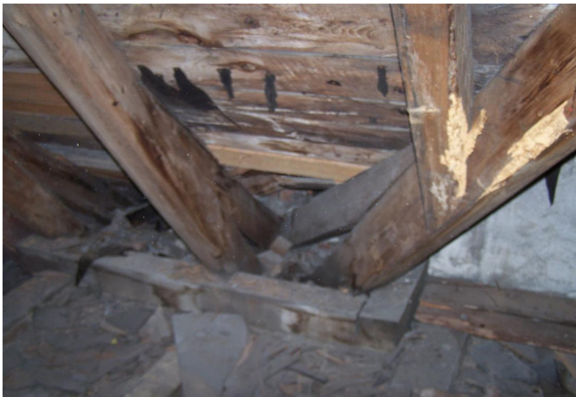
Fotografia nr 15 – Więźba dachowa usztywniona stalową ramą. Południowo wschodnie belki porażone są przez owada spuszczała Hylotrupes bajulus .
