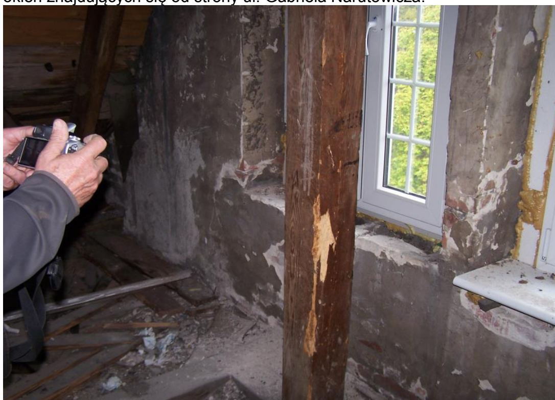
Fotografia nr 14 – Więźba dachowa usztywniona stalową ramą. Na fotografii widoczny jest słup porażony przez owada spuszczela Hyloterpes bajulus . Słup znajduje się na lewo od okien znajdujących się od strony ul. Gabriela Narutowicza.
