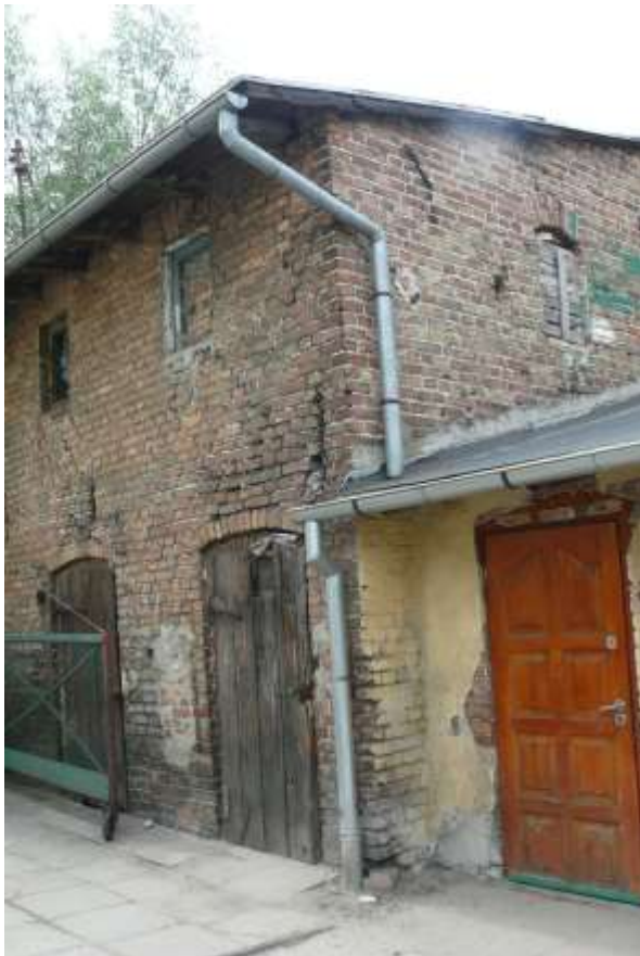
Fot. 2. Widok budynku gosp. do rozbiórki.
