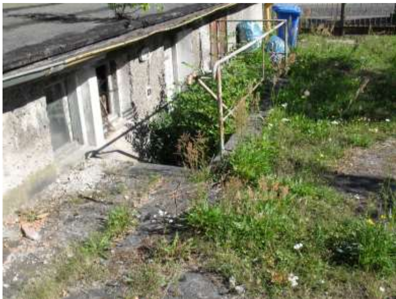
Fot.1. Widok kotłowni do rozbiórki.
