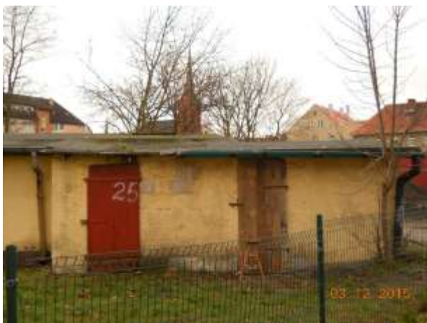
Fot. 3. Widok komórek gospodarczych do rozbiórki.
