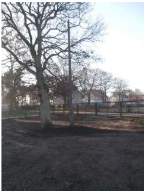
Fot.4. Słup oświetleniowy do rozbiórki.
