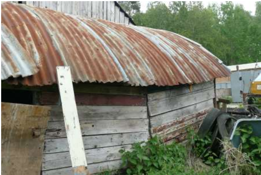
Fot.5. Dobudowane pomieszczenia od strony zachodniej.
