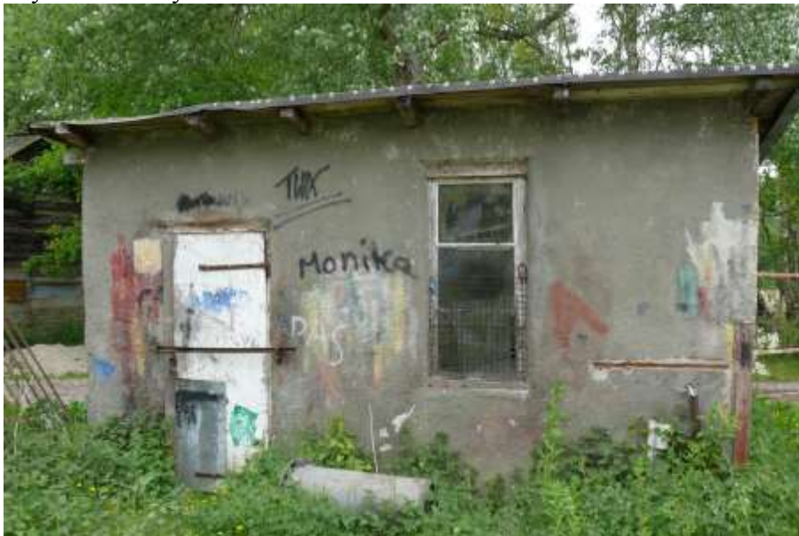
Fot.6. Budynek gosp. murowany.
