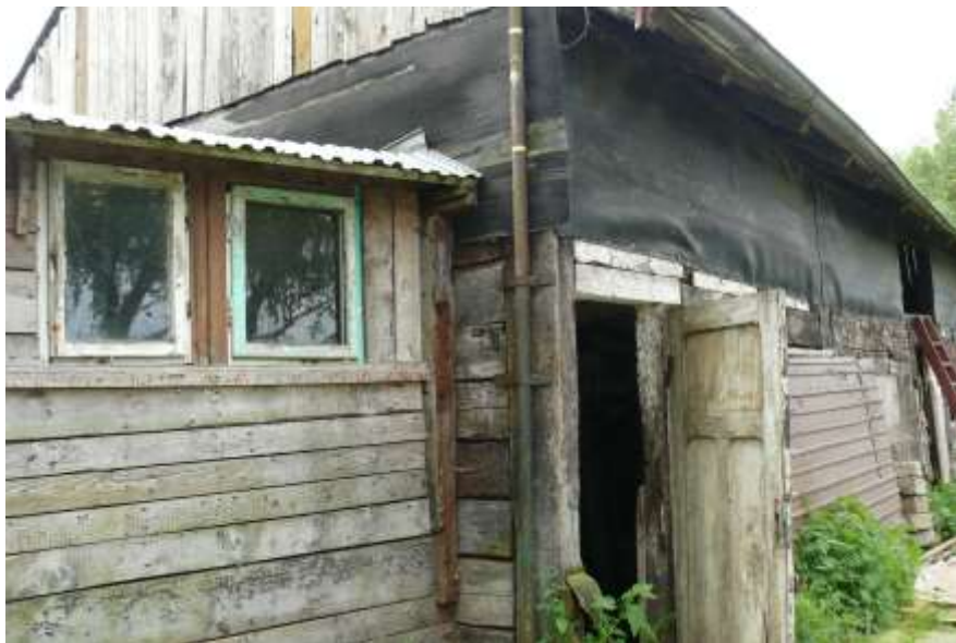
Fot.3. Dobudowane pomieszczenie gosp. Od strony wschodniej.
