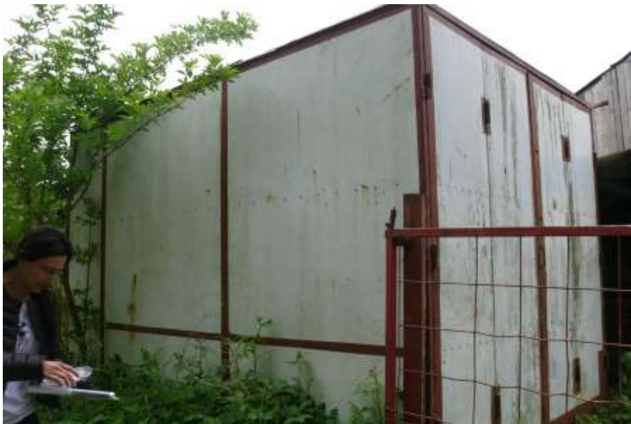
Fot. 7. Kontener stalowy.
