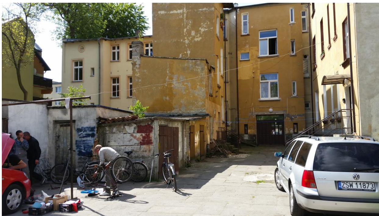
Fot. nr 2. Widok elewacji bocznej.
