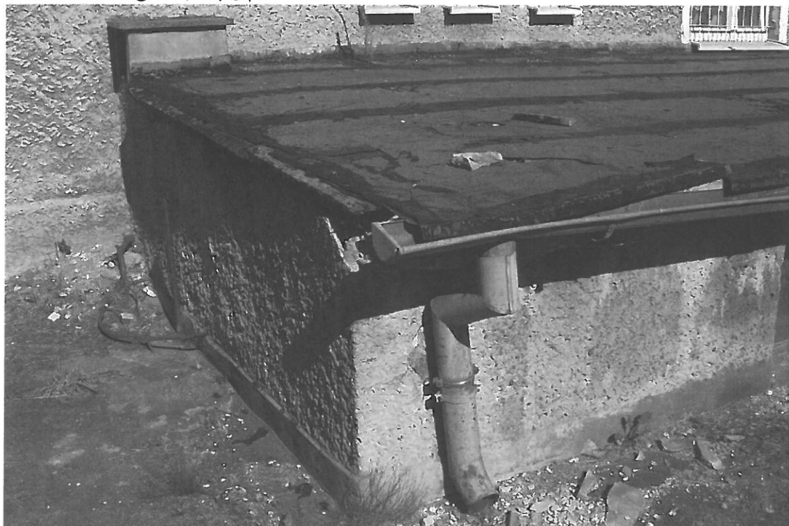
FOT. 4 WIDOK NA FRAGMENT KOTŁOWNI
