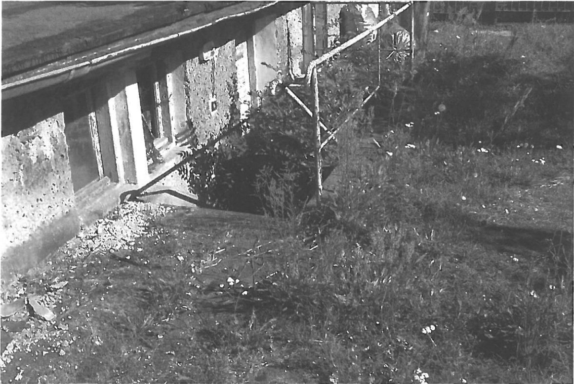
FOT. 1 WIDOK KOTŁOWNI
