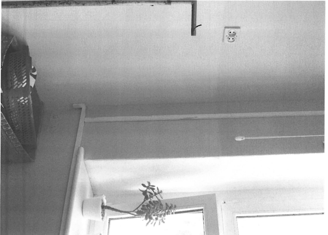
FOT. 2 INSTALACJE NATYKOWE DO SCHOWANIA POD TYNK. SALA 22
