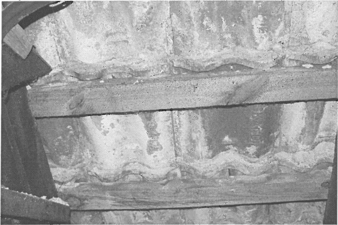
FOT. 16 WIDOK NA PRZEKROJE DACHOWE
