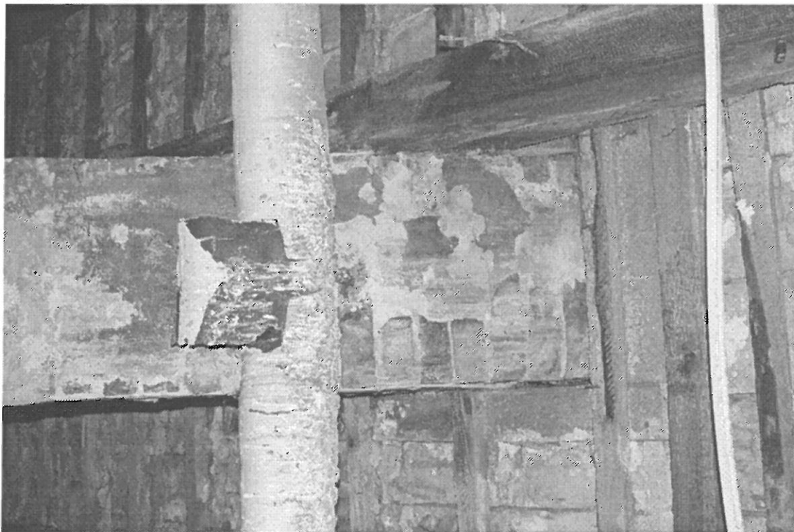
FOT. 12 KOMIN DO REMONTU.
