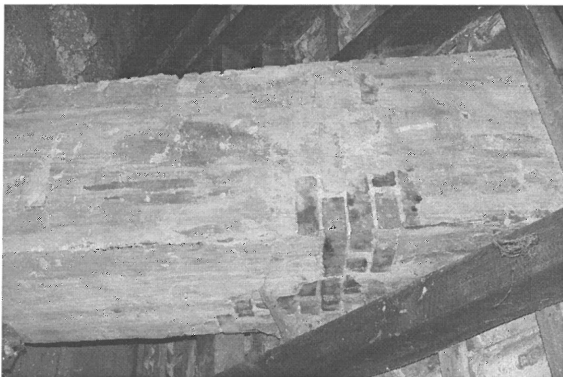
FOT. 13 KOMIN DO REMONTU.
