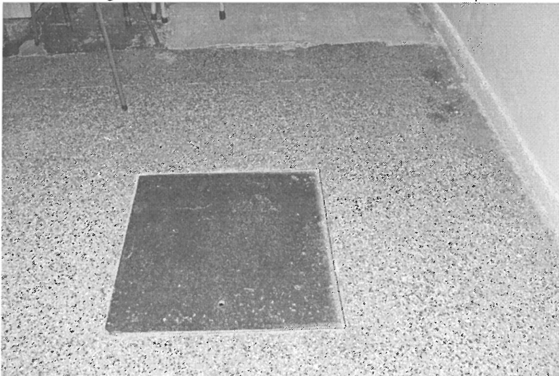
FOT.1 ISTNIEJĄCA STUDZIENKA (ZAKŁADANA ZOSTANIE REWIZJA STALNA)
