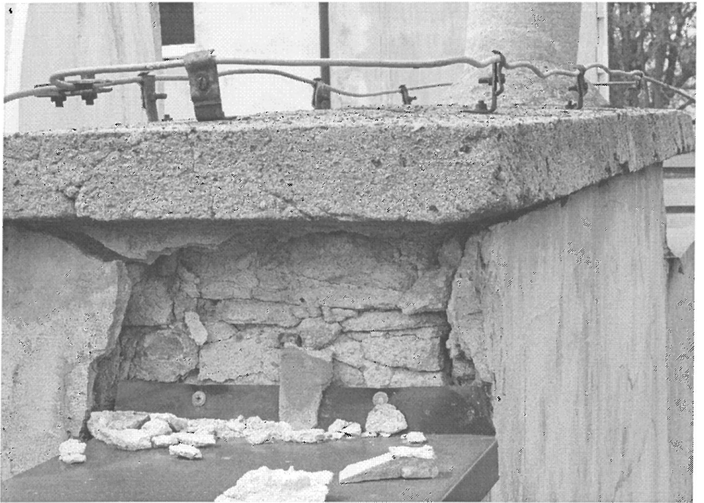
FOT. 8 DACH NAD MIESZKANIAMI KOMIN DO REMONTU.
