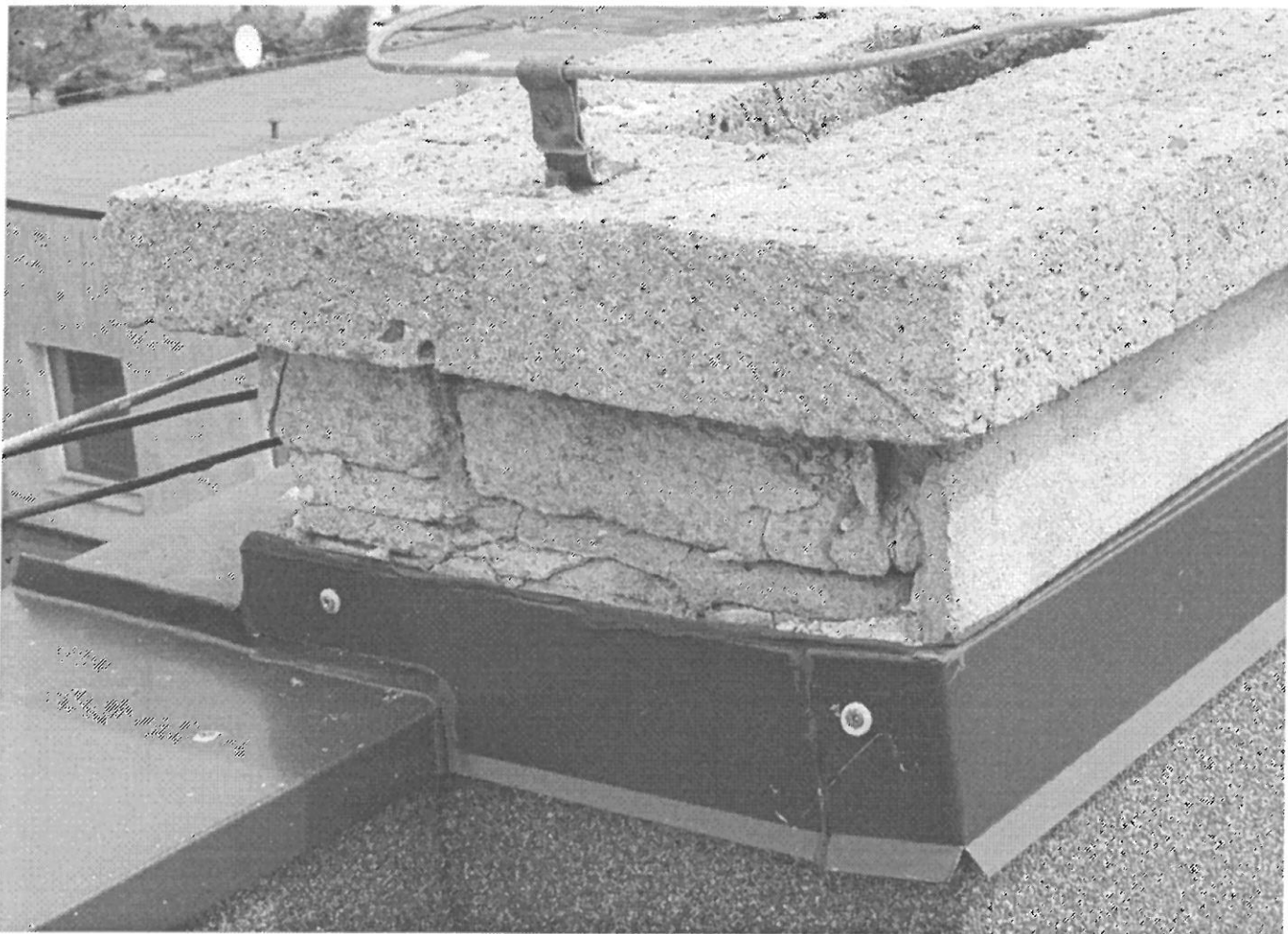
POT. 5 DACH WYSOKI STAN TECHN. KOPINGU LENT. DO REMONTU.
