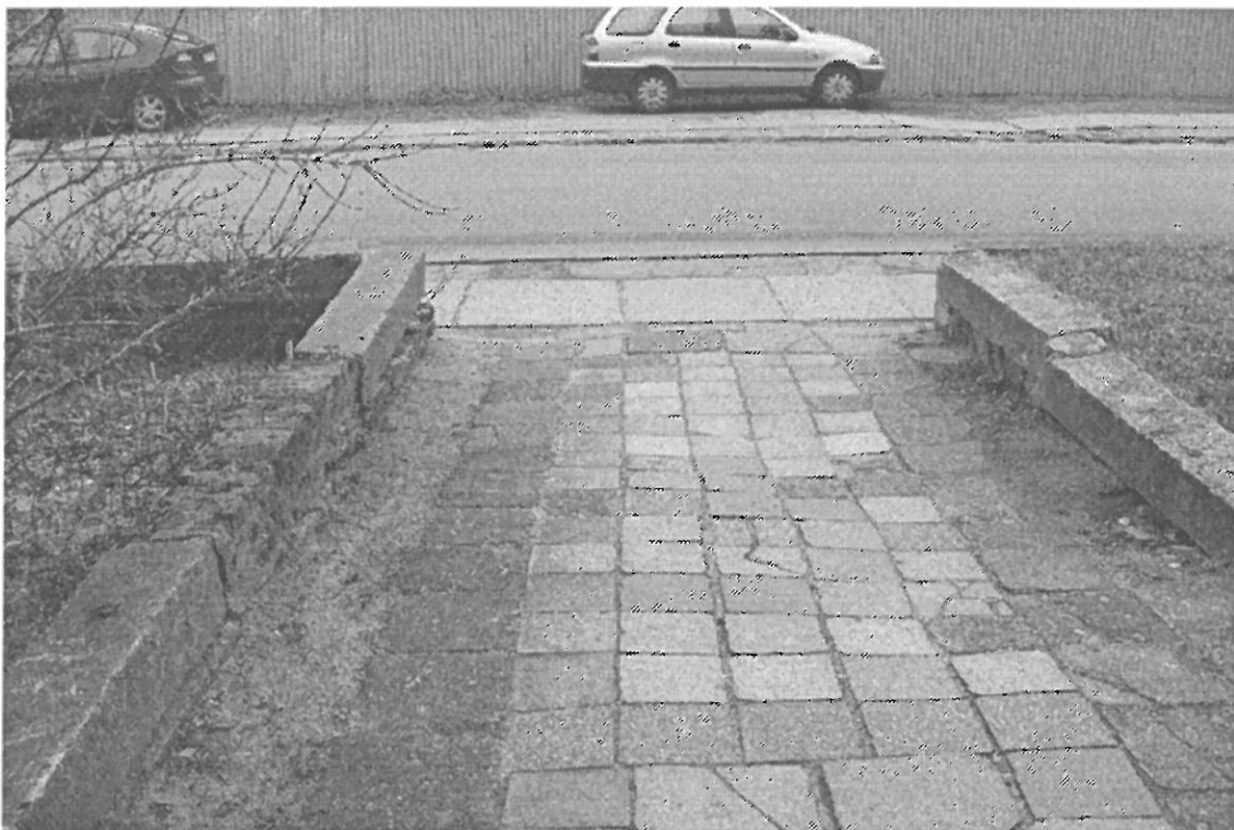
FOT. 5 DOJŚCIE DO WEJŚCIA GŁÓWNEGO BUDYNKU - DO ROZBIÓRKI.
