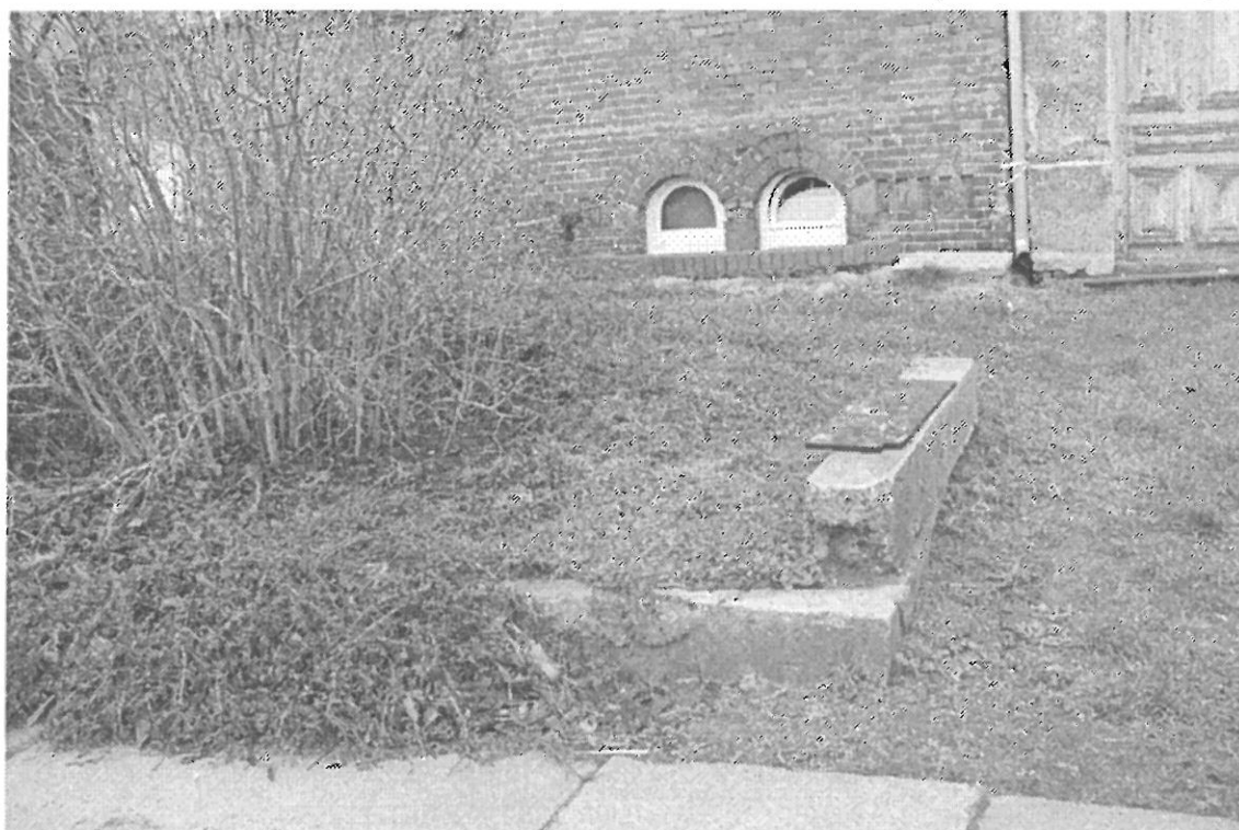
FOT. 4 TEREN PRED BUDOVANEM. MURUŤ OROBUJE DO ROZBIŤKY, ZIELEN DO PODCINY.
