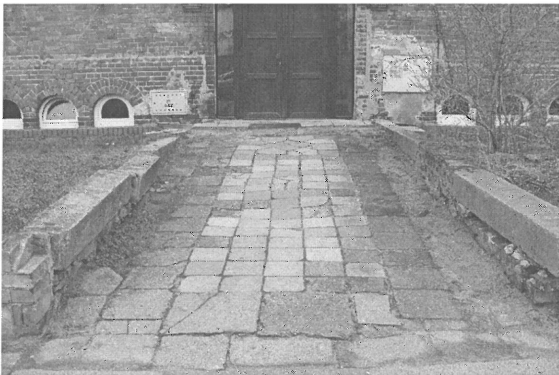
FOT. 6 J.W. WIDOCZNE MURKI OPOROWE PO OBU STRONACH DOJŚCIA - DO ROZBIÓRKI.
