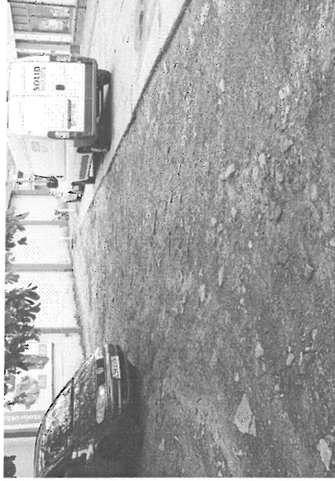
FOT.2 NAWIEZCZYNIA GARNYCHA ZAGRYZOWANA DO OCYSZCZENIA I NIWELACJI
