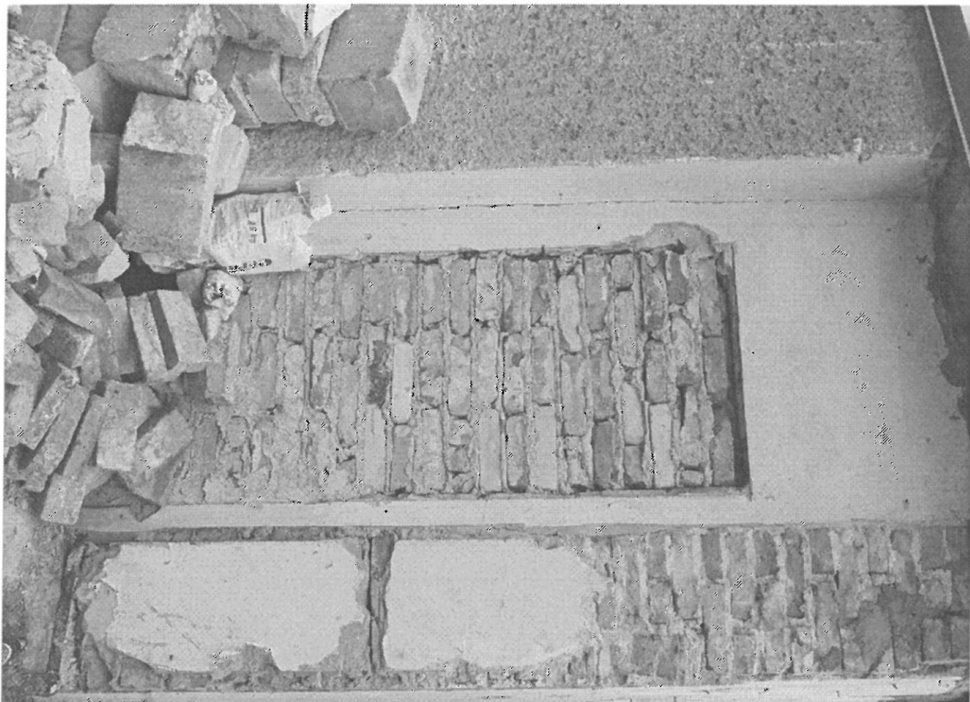
FOT. 3 WNEKA DO ZAMUROWANIA I OTRĄDNIANIA.
