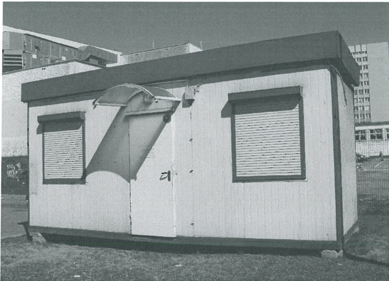
FIG. 1 KONTENER SPOŁECZNY, WIDOK ELEWACJI PRZONTOWEJ
