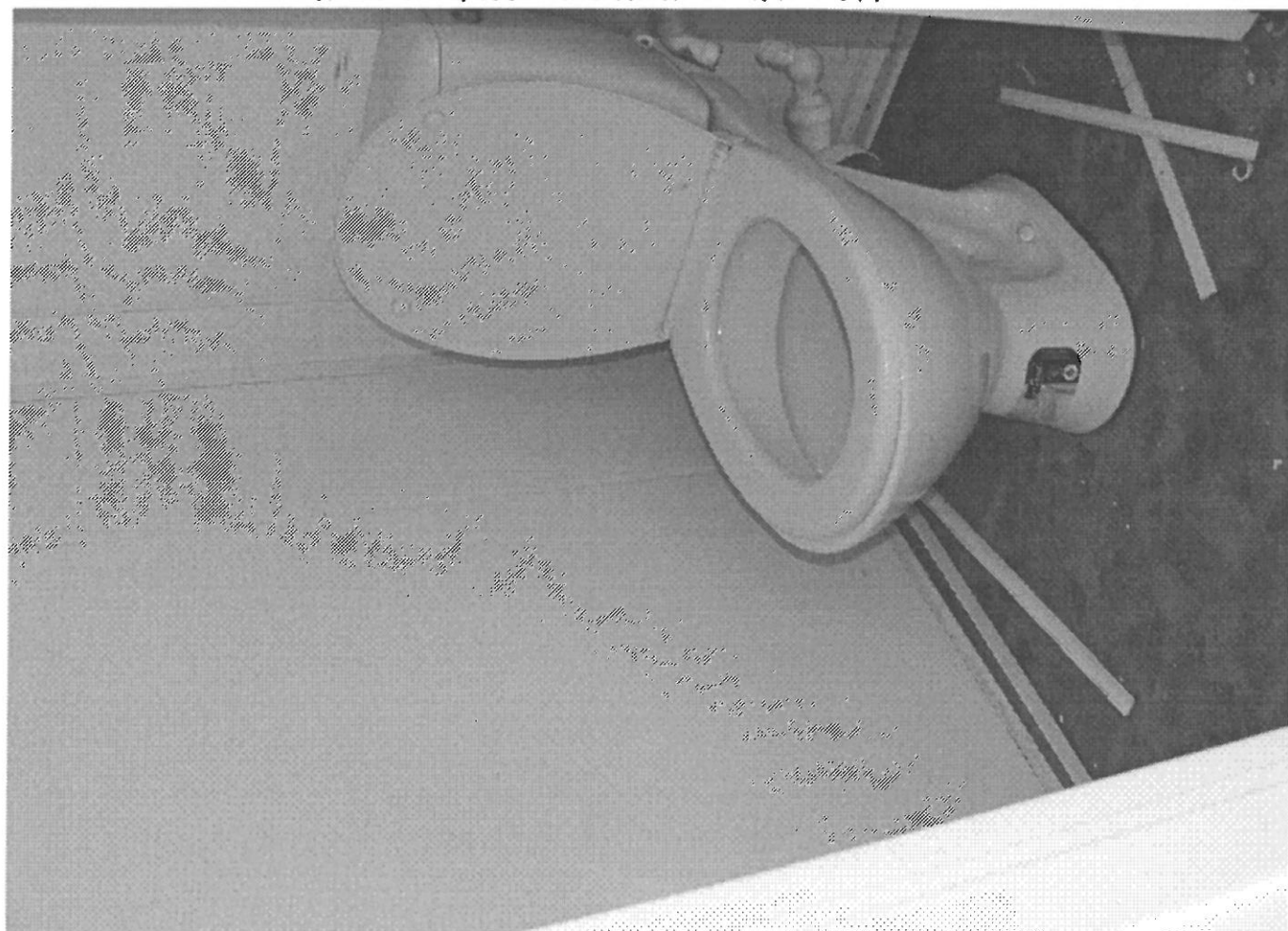
FOT. 6 URZĄDZENIE SANITARNE DO DEMONTAŻU.
