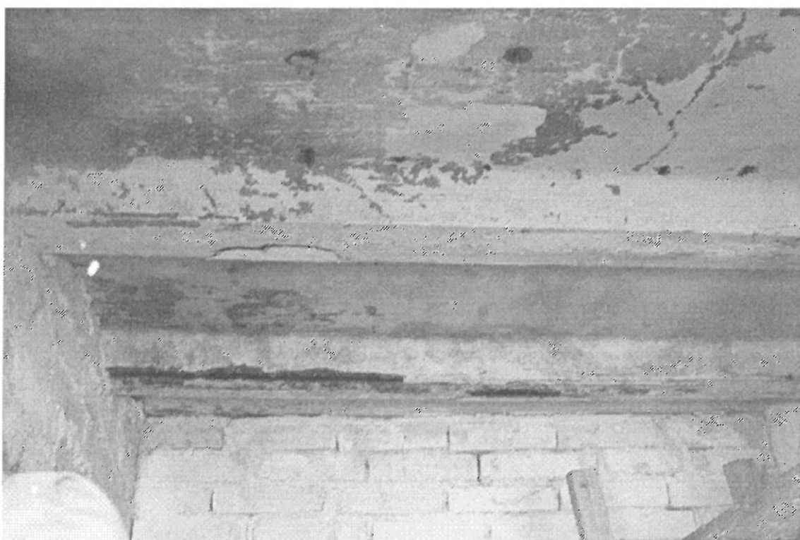
ul. A. KRADZUJEJ 12 (STROP Z PIAT KORYTROWYCH)
