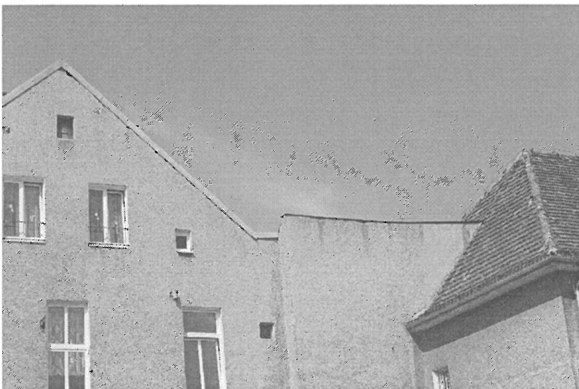
FOT. 2 WIDOK TAKIWEJ ELEWACJI DACHU J.W.
