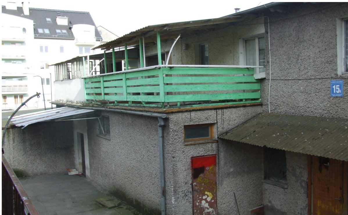
Fot. nr 2. Widok elewacji frontowej (budynek oficyny).
