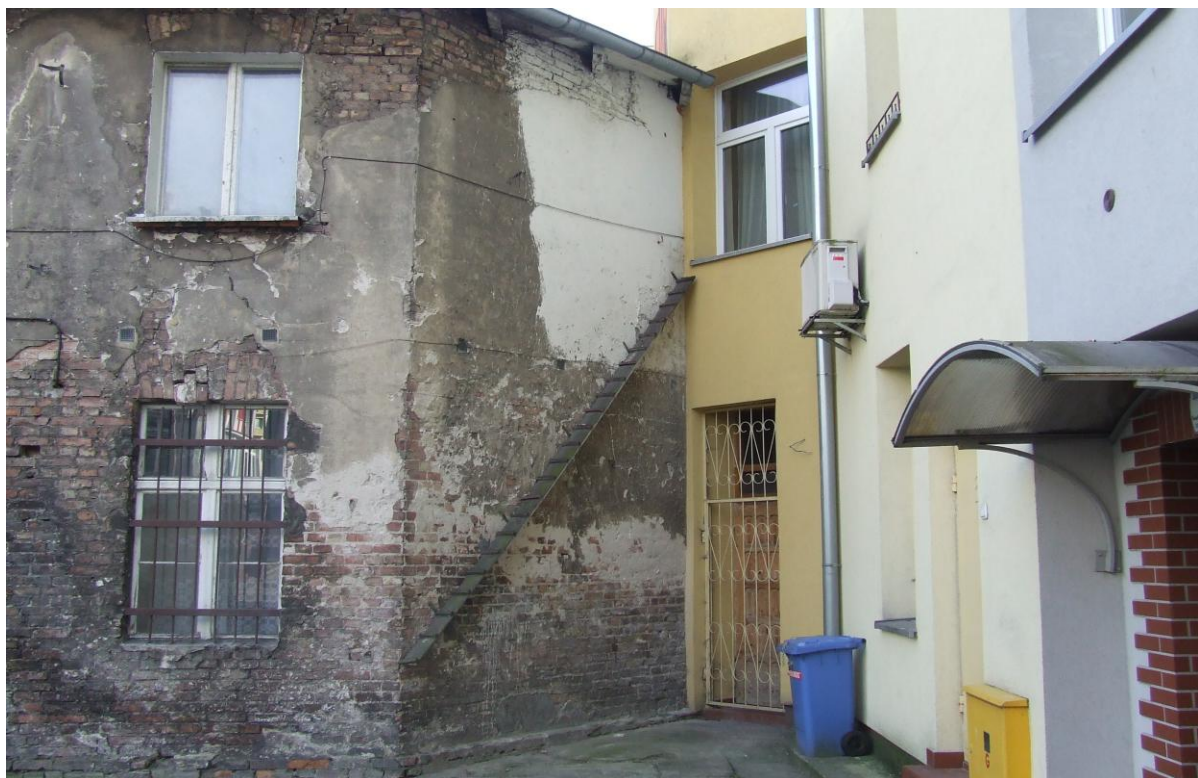
Fot. nr 3. Widok miejsca styku budynków (budynek oficyny).
