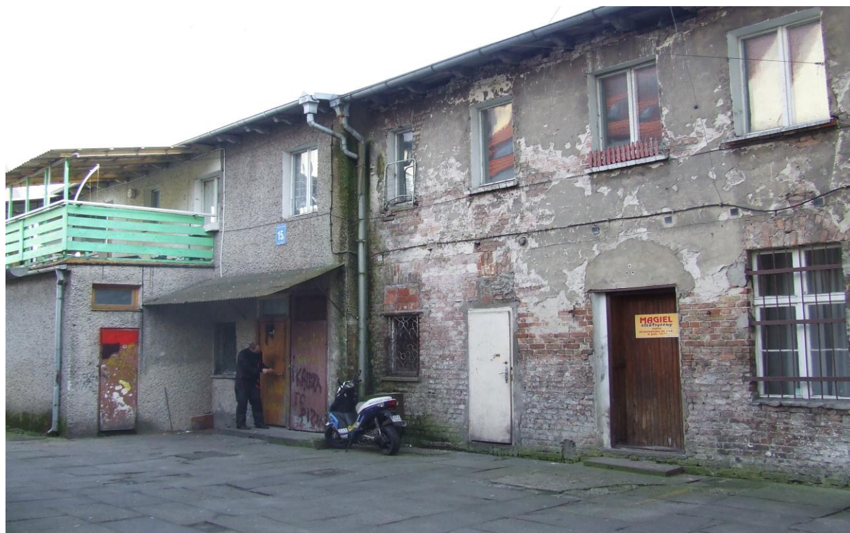
Fot. nr 1. Widok elewacji frontowej (budynek oficyny).
