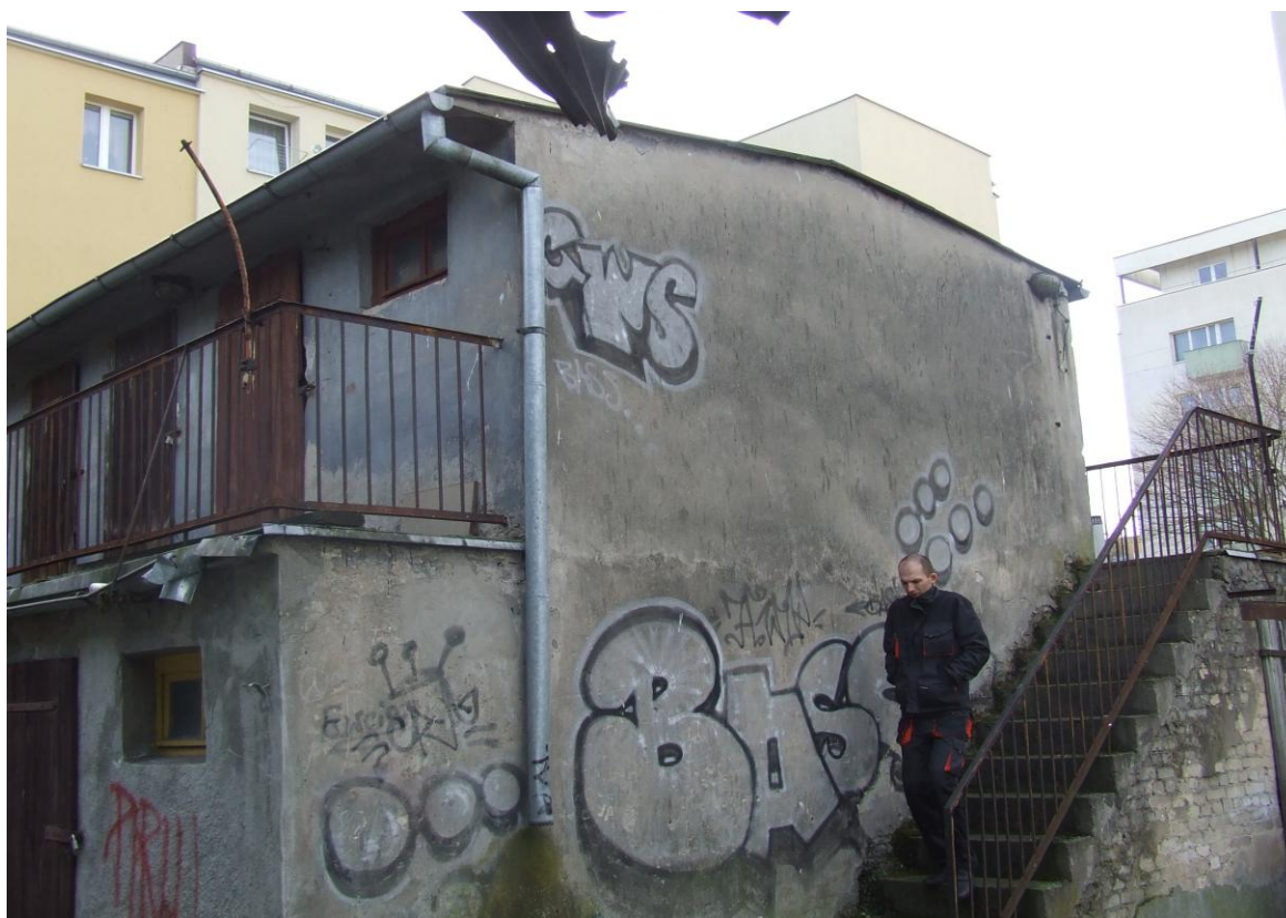
Fot. nr 7. Widok elewacji bocznej budynku gospodarczego
