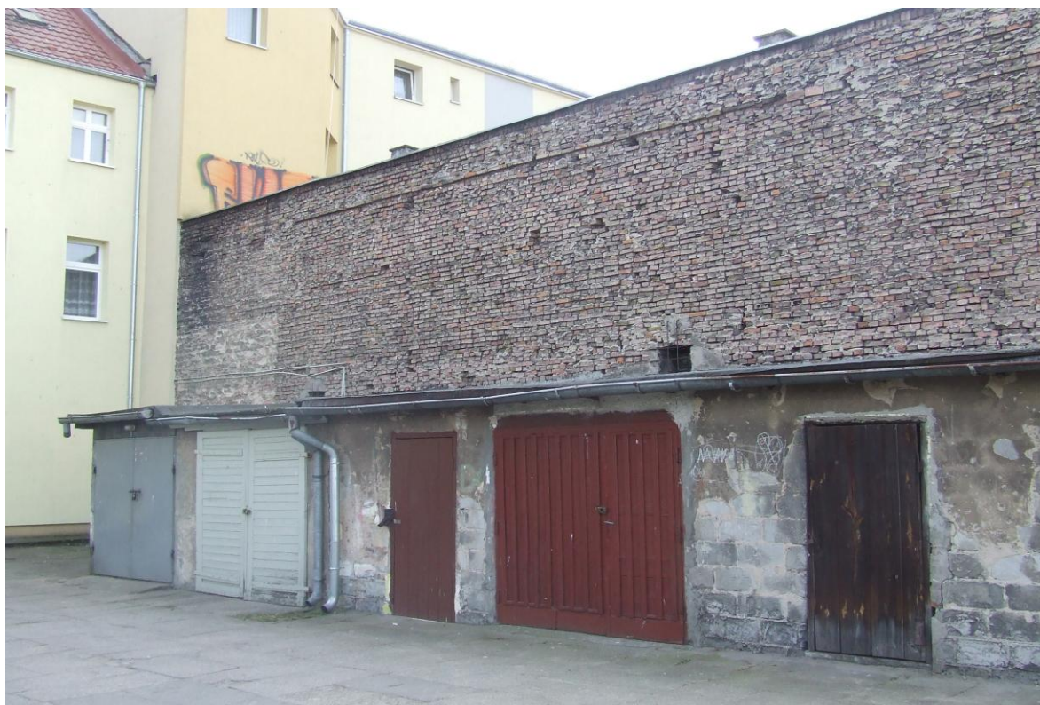
Fot. nr 4. Widok elewacji tylnej (budynek oficyny).
