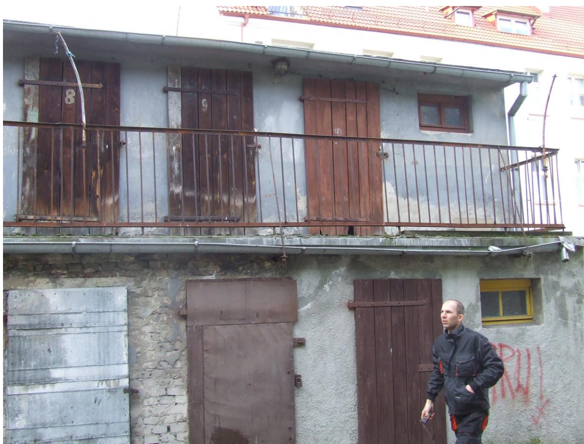
Fot. nr 5. Widok elewacji frontowej budynku gospodarczego.
