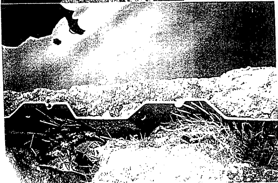
Istniejąca stalowa ścianka szczelna typu „KŁOCNER”
